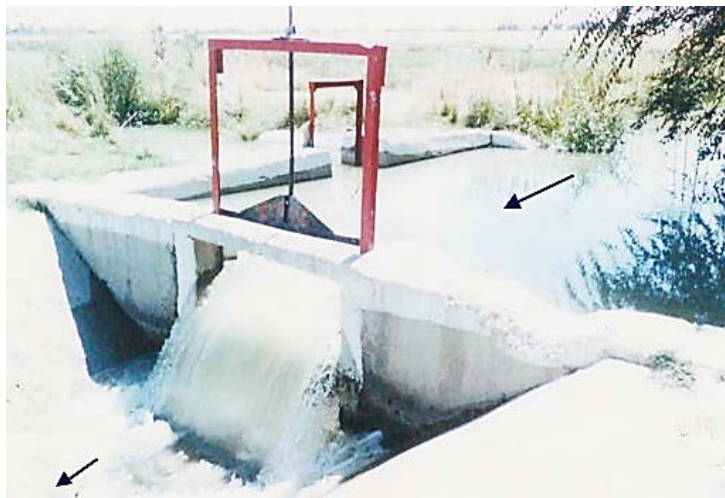
Рис. 2.10. Затвор-водомер на Р-7-13 прямо АМК.
