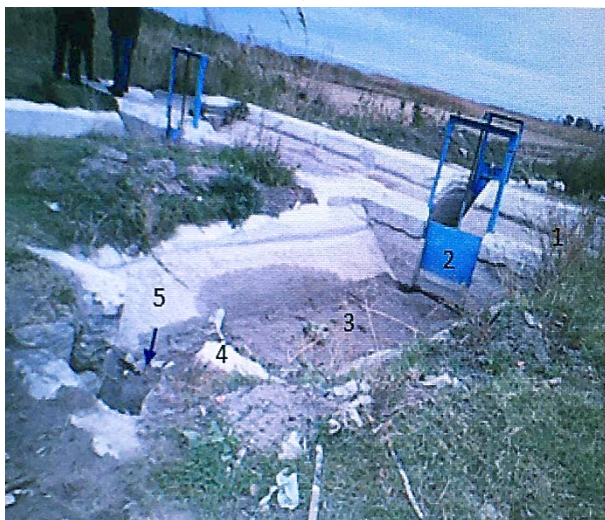
Рис. 2.9. Водомер с водосливом и колодцем-гасителем. 1 – канал; 2 – отвод; 3 и 4 – затворы; 5 – колодец-гаситель; 6 – водослив; 7 – сквозная стенка.
