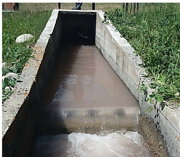
Рис. 2.7. Отвод «Садовый» (а) МК «Туш» и прямоугольный водослив (б) без боковых сжатий.
