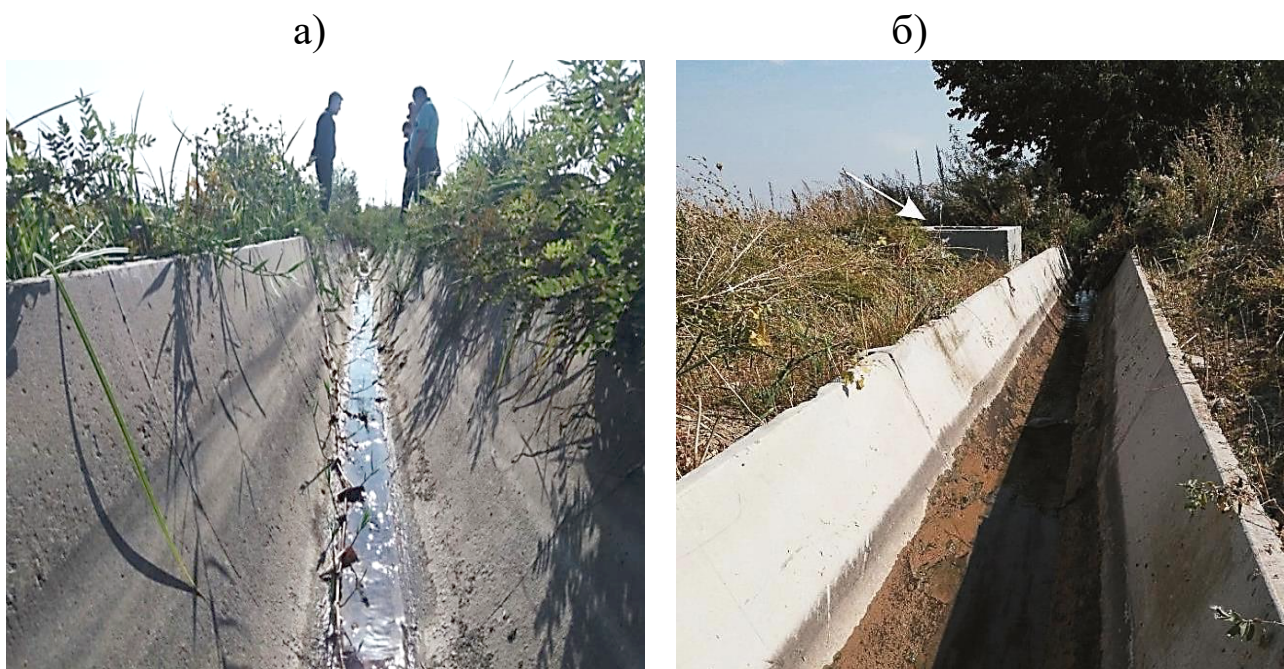
Рис. 1.1. На фото видны следы прохождения максимальных расходов воды по каналу (а) и гидросту (б); глубины H_{max} в них не превышает 0,5H_d .
