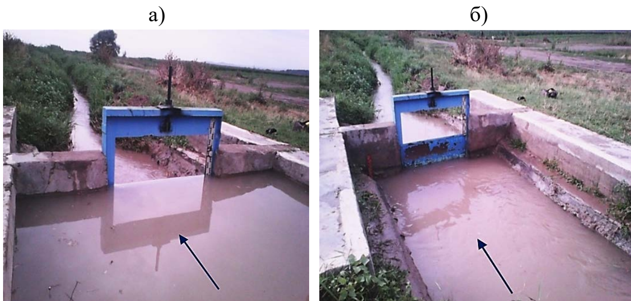
Рис. 4.2. Водомер типа «Водослив-насадок» на Р-8 ЗБЧК в работе водослива (а) и насадка (б).
