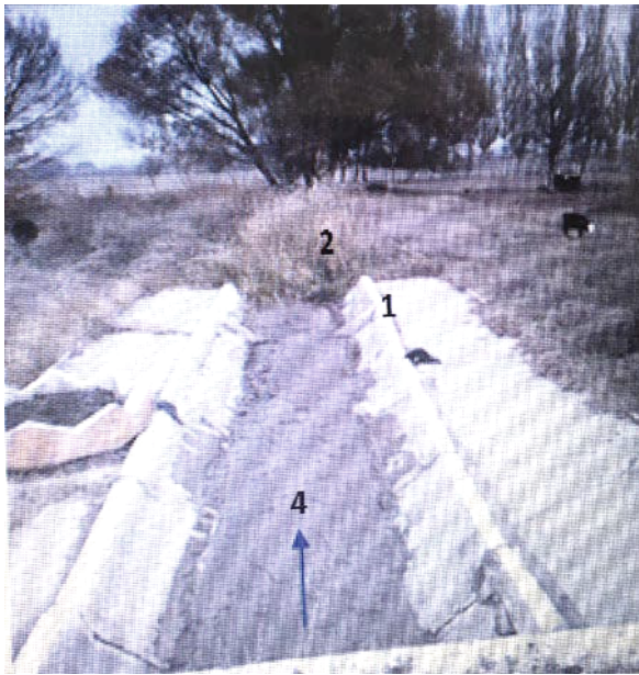
Рис. 2.2. Водомер с водосливом (1); 2 – отвод в земляном русле.
