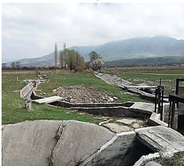
Рис. 2.7. Отвод «Садовый» (а) МК «Туш» и прямоугольный водослив (б) без боковых сжатий.
