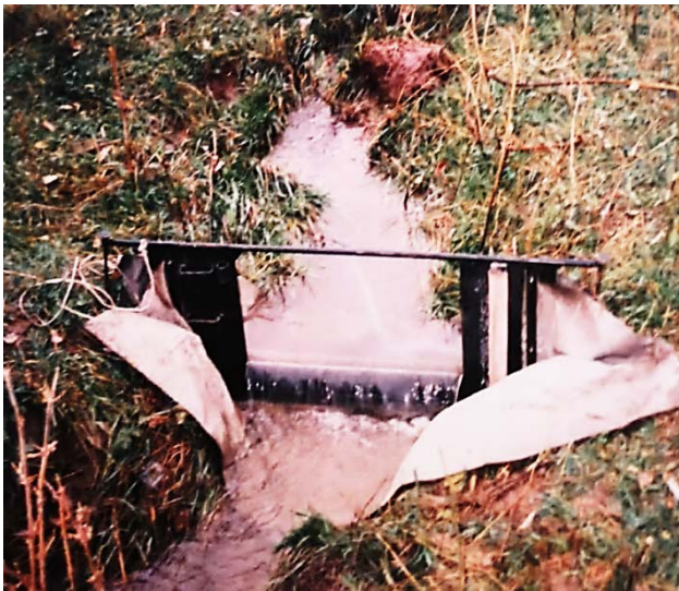
Рис. 2.1. Переносные водосливы в работе.
