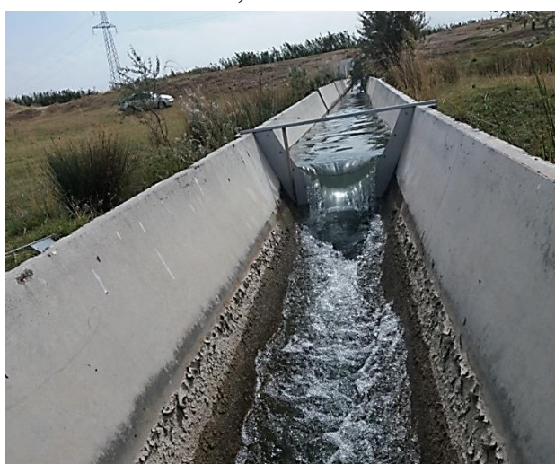
Рис. 2.8. Переносные водосливы трапецеидального (а) и параболического (б) сечений в работе (лотки работают не полным сечением).
