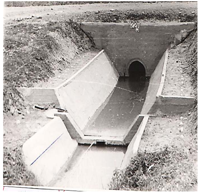
Рис. 2.3. Водомер с водосливом и наносопромывным отверстием.
