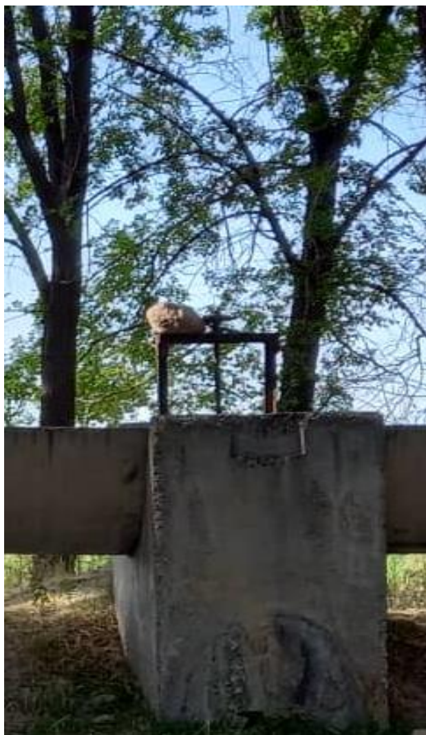
Рис. 7.3. Водовыпуски траншейного типа.
