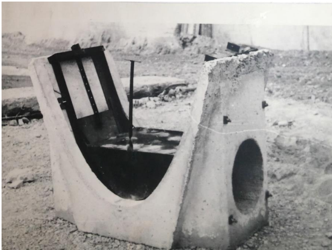
Рис. 3.7. Новые блоки ВС и ДВС для вододелителей лотковых каналах (на Ленинском полигоне Кен-Булунского ЖБИ).
