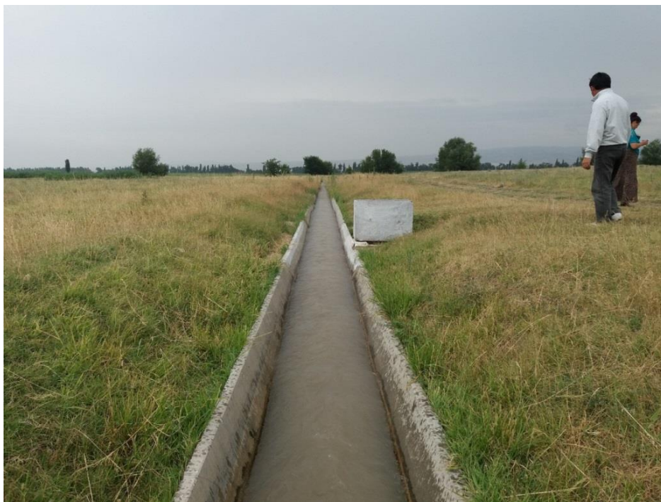
Рис. 1.10. Водомерное сооружение типа «Фиксированное русло» на Р-1-5 Новый ЗБЧК.
