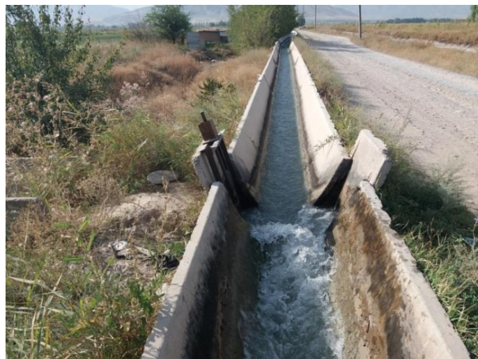
Рис. 3.5. Удлиненные траншейные водовыпуски с плоскими щитами перед трубчатым отводами воды.
