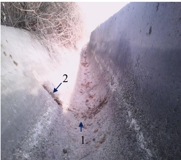
Рис. 2.9. Водомер типа «Фиксированное русло» на лотковом канале «Жантай» системы реки Ала-Арча. а – общий вид с верхнего бьефа; б – вид сбоку. 1 – лоток; 2 – щель; 3 – уровнемерный колодец.
