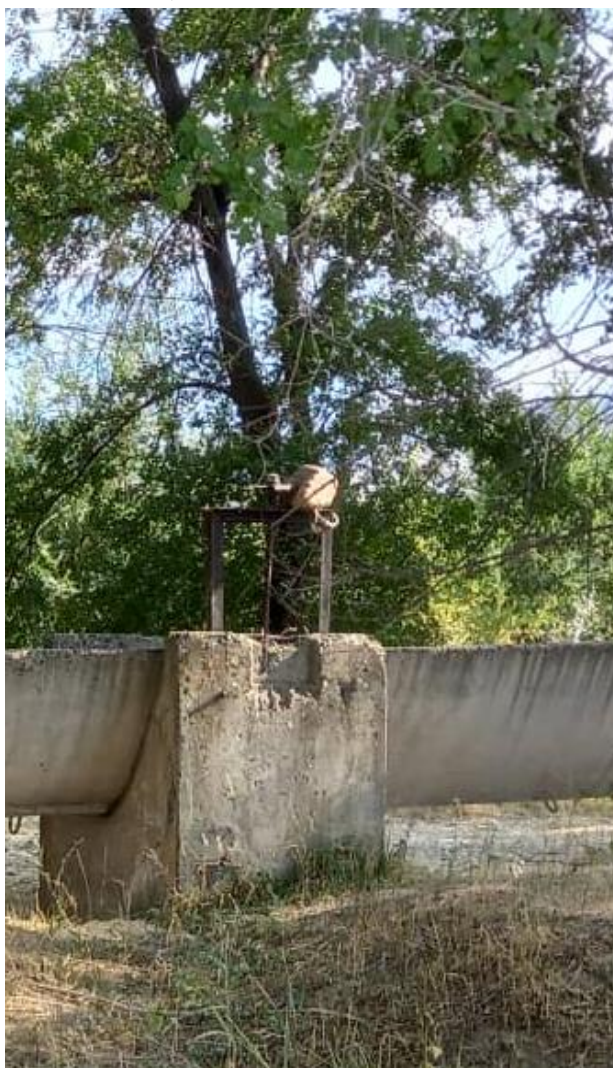
Рис. 7.3. Водовыпуски траншейного типа.
