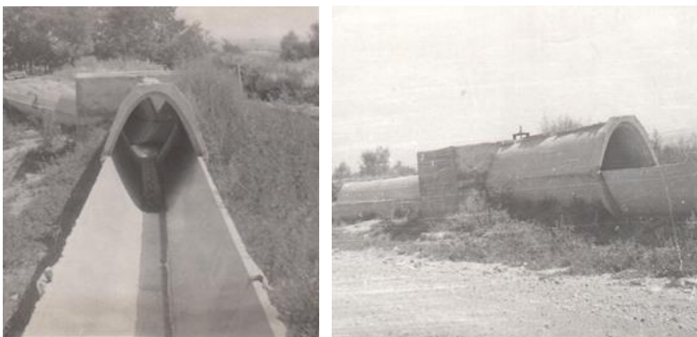
Рис. 5.3. Ломанные в плане поворотные сооружения на быстротечных лотковых каналах.
