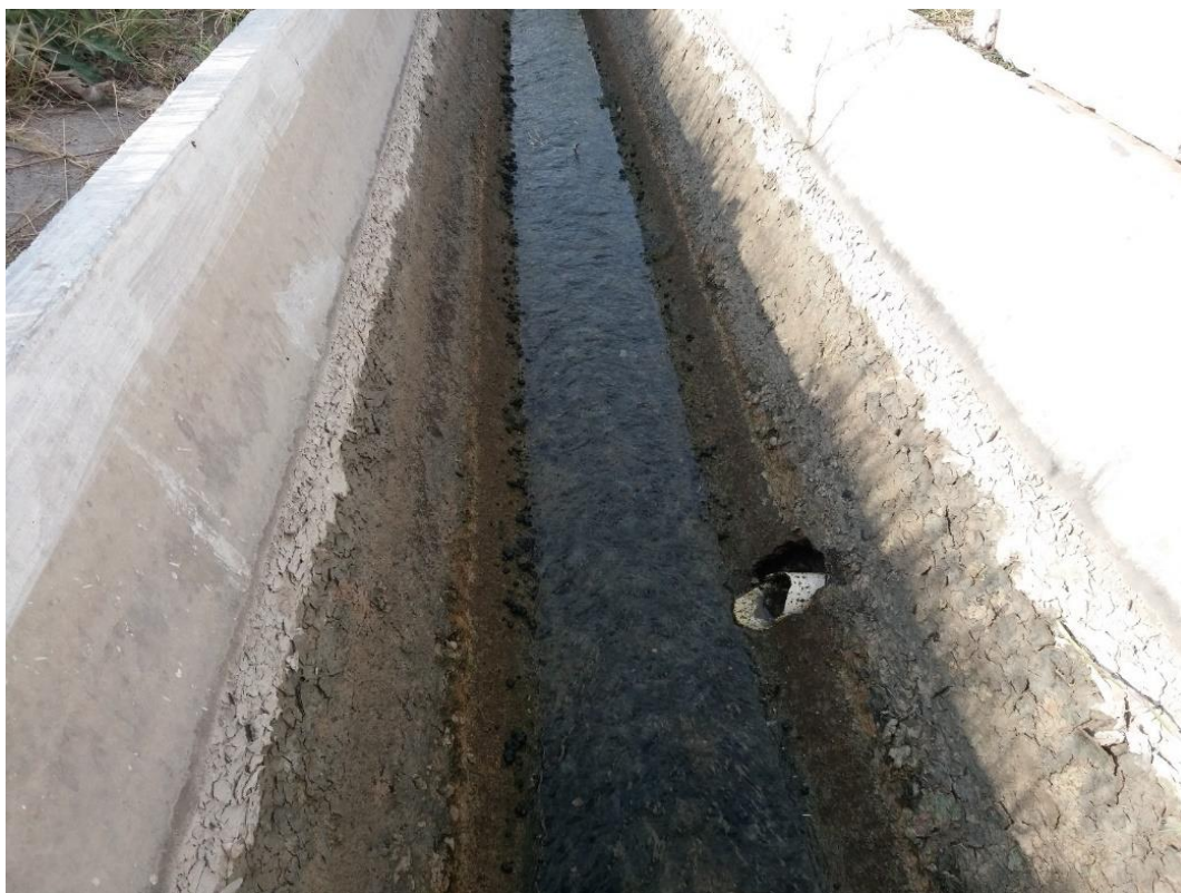
Рис. 2.25. Неправильное размещение соединительной трубы отрицательно скажется на пропускную способность водомера (не только нарушается режим течения воды в водотоке, но, наравне с ним, резко повышается и погрешность измерения расходов воды).
