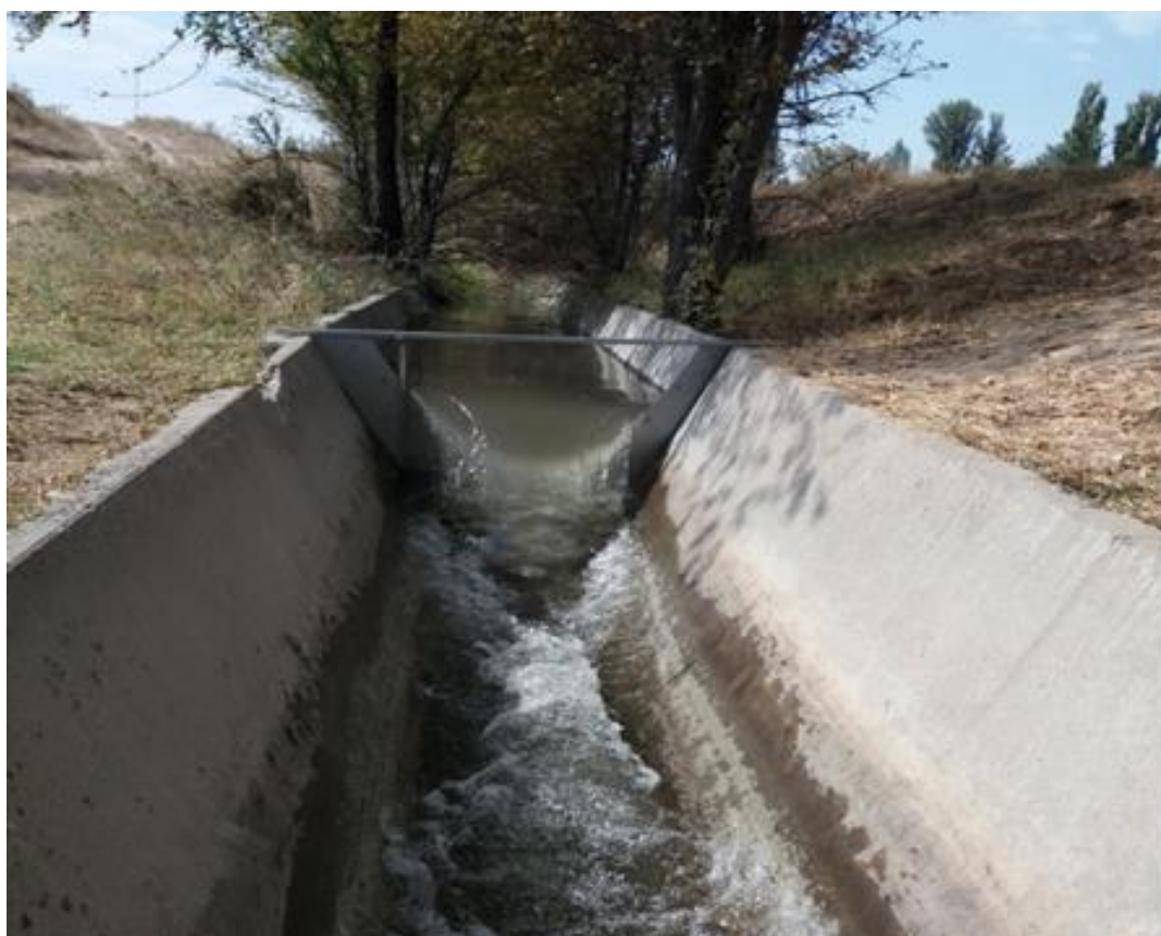
Рис. 2.20. Параболический водослив на лотковом канале Подпитка 1 в работе. а, б – соответственно вид с верхнего и нижнего бьефов.
