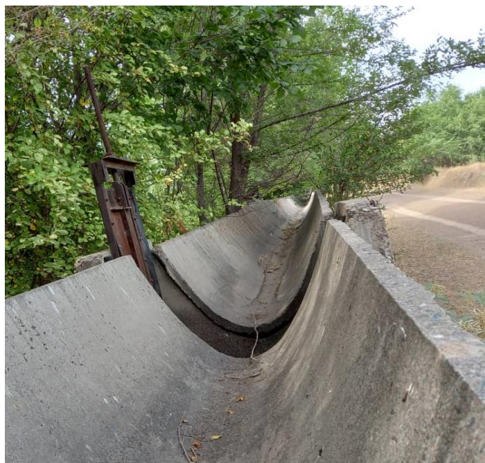
Рис. 7.2. Водовыпуск траншейного типа.
