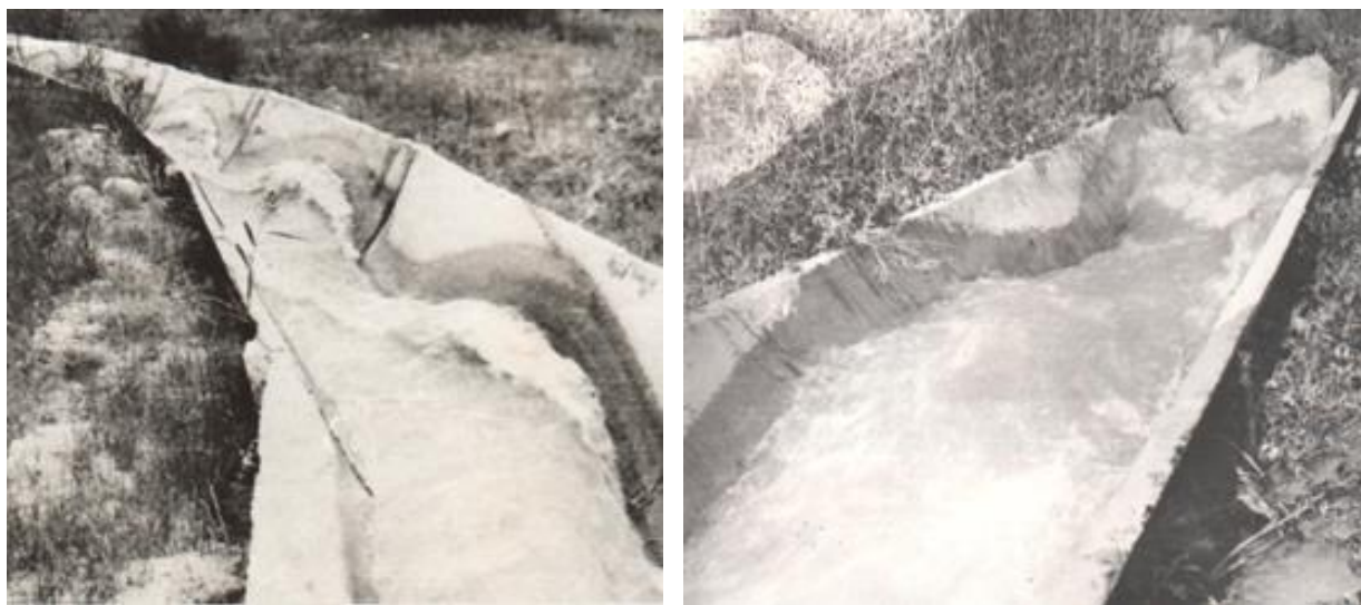
Рис. 5.1. Поворотные сооружения «по дуге круга» на каналах с бурным режимом течения воды.
