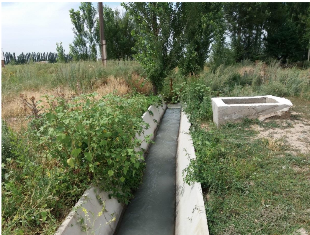
Рис. 2.10. Водомерное сооружение типа «Фиксированное русло» на канале «Левый Запад», ЮБЧК.
