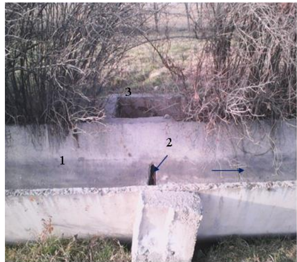
Рис. 2.9. Водомер типа «Фиксированное русло» на лотковом канале «Жантай» системы реки Ала-Арча. а – общий вид с верхнего бьефа; б – вид сбоку. 1 – лоток; 2 – щель; 3 – уровнемерный колодец.
