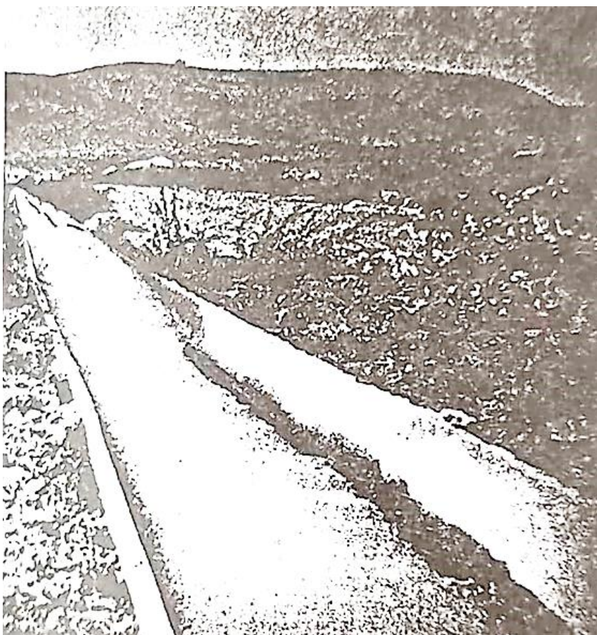
Рис. 1.3. Изменение гидравлических элементов потока в лотковом канале Токбай вызвано переломом его уклона.
