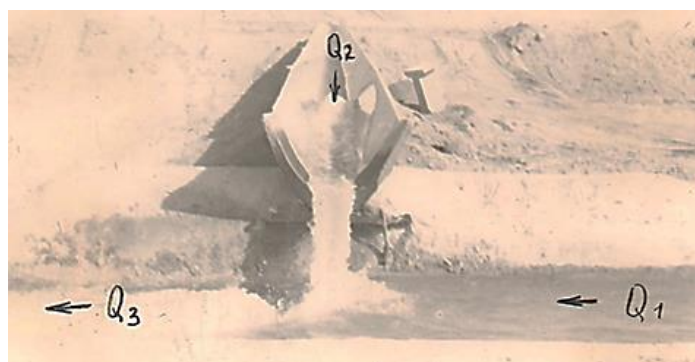
Рис. 4.1. Подпитывающее сооружение на оросительной системе р.Исфара.
