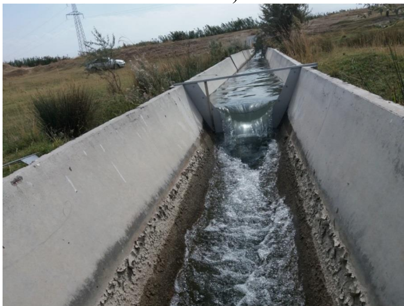
Рис. 2.19. Параболический водослив на лотковом канале Подпитка 2 в работе. а, б – соответственно вид с верхнего и нижнего бьефов.
