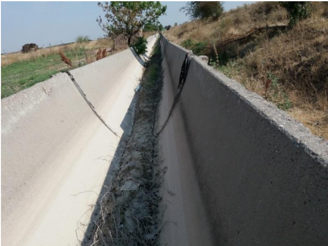
Рис. 1.13. Несмотря на частичное прилипание ила на поверхности канала, глубина воды в нем H \leq \frac{1}{2} H_{л} .
