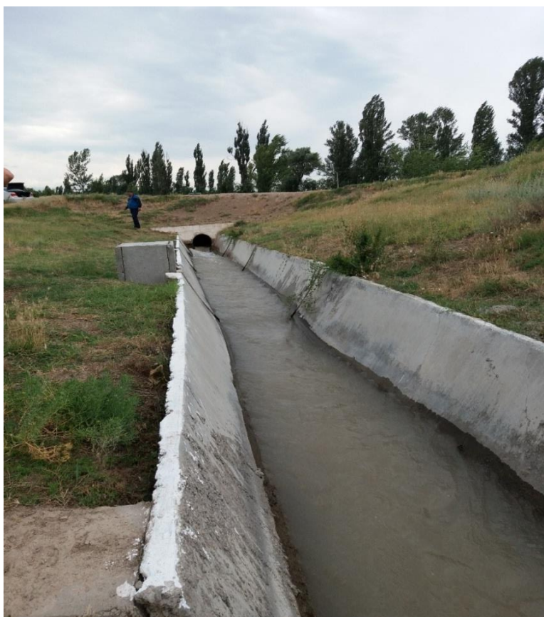
Рис. 2.12. Водомерное сооружение типа «Фиксированное русло» на канале Подпитка №1 ЗБЧК.
