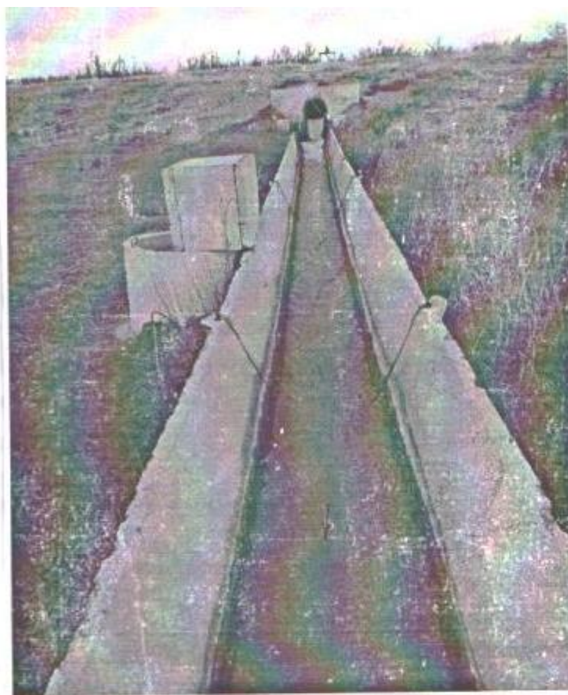
Рис. 2.7. Водомерное сооружение типа «Фиксированное русло» на канале Подпитка №2 ЗБЧК.
