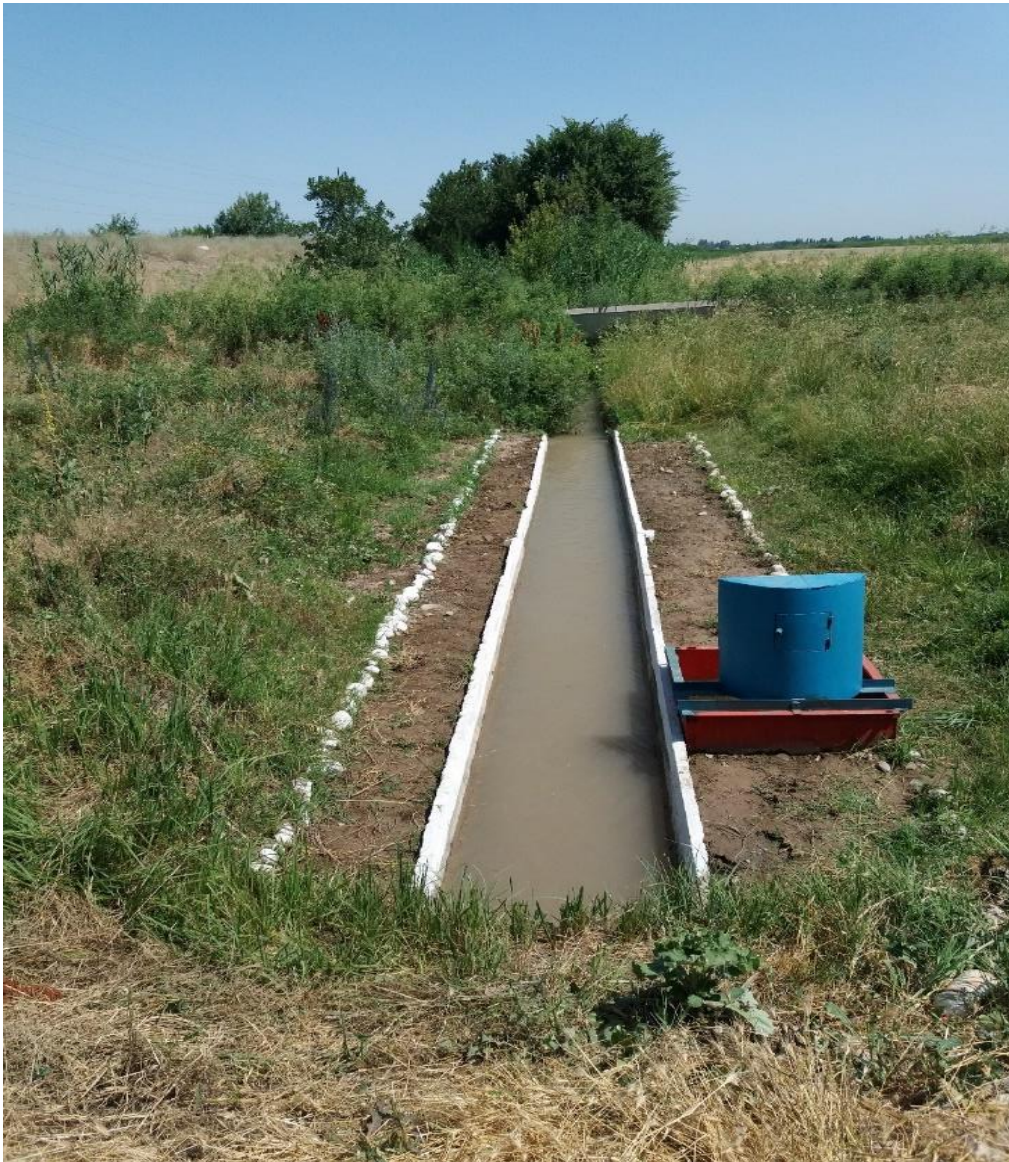
Рис. 1.8. Водомерное сооружение типа «фиксированное русло» на Р-11-1 системы ЗБК.
