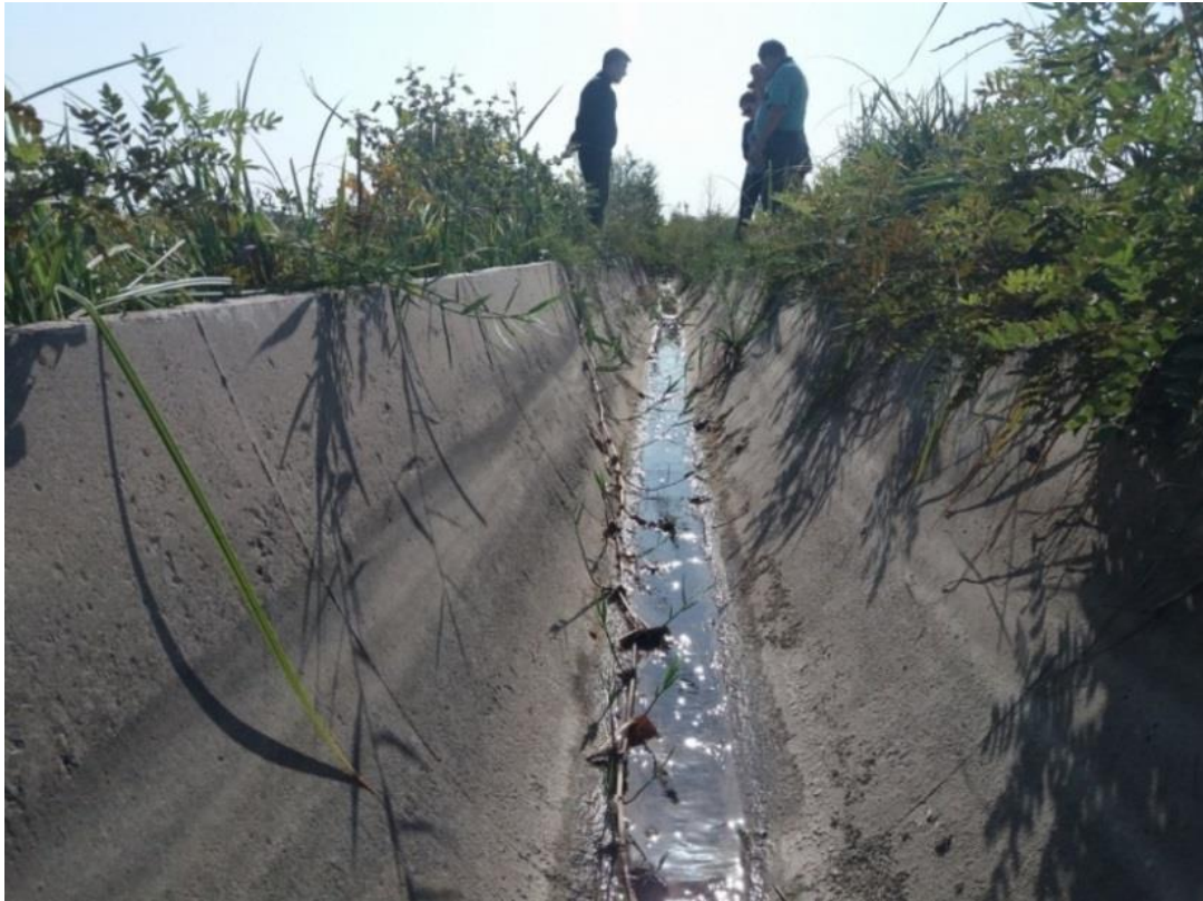
Рис. 1.12. На фото видны следы прохождения максимального расхода воды. При этом H \approx \frac{1}{2} H_{л}
