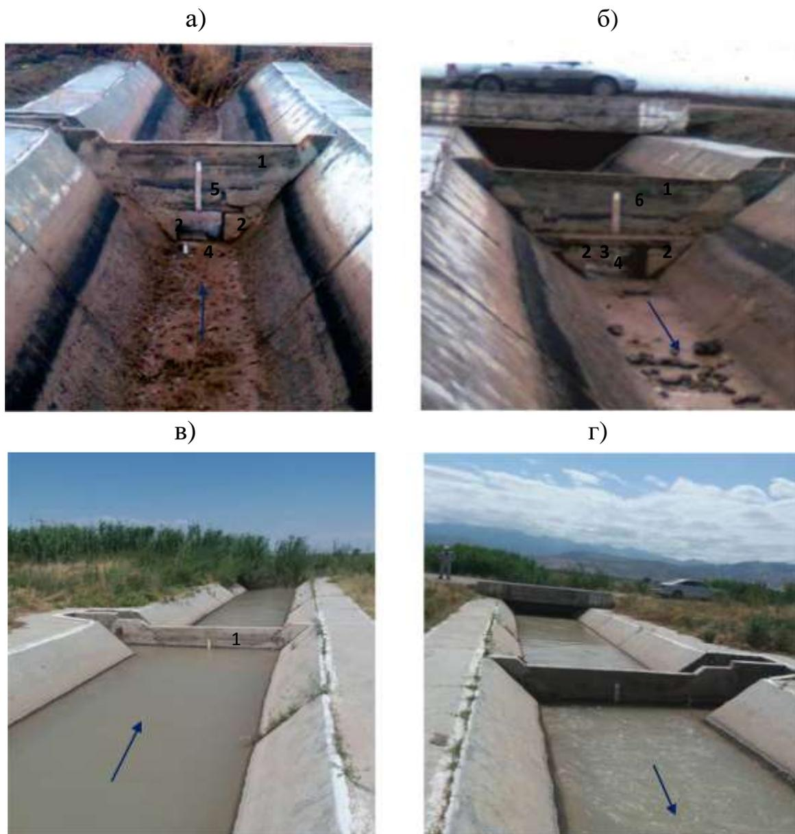
Рис. 3.21. Водомерное сооружение типа «Прямоугольный насадок» на Р-23 системы ВБЧК. а, в – виды с верхнего бьефа; б, г – виды с нижнего бьефа. 1 – диафрагма; 2 – низкие ныряющие стенки; 3 – плита перекрытия; 4 – водопропускное отверстие; 5, 6 – уровнемерные рейки.
