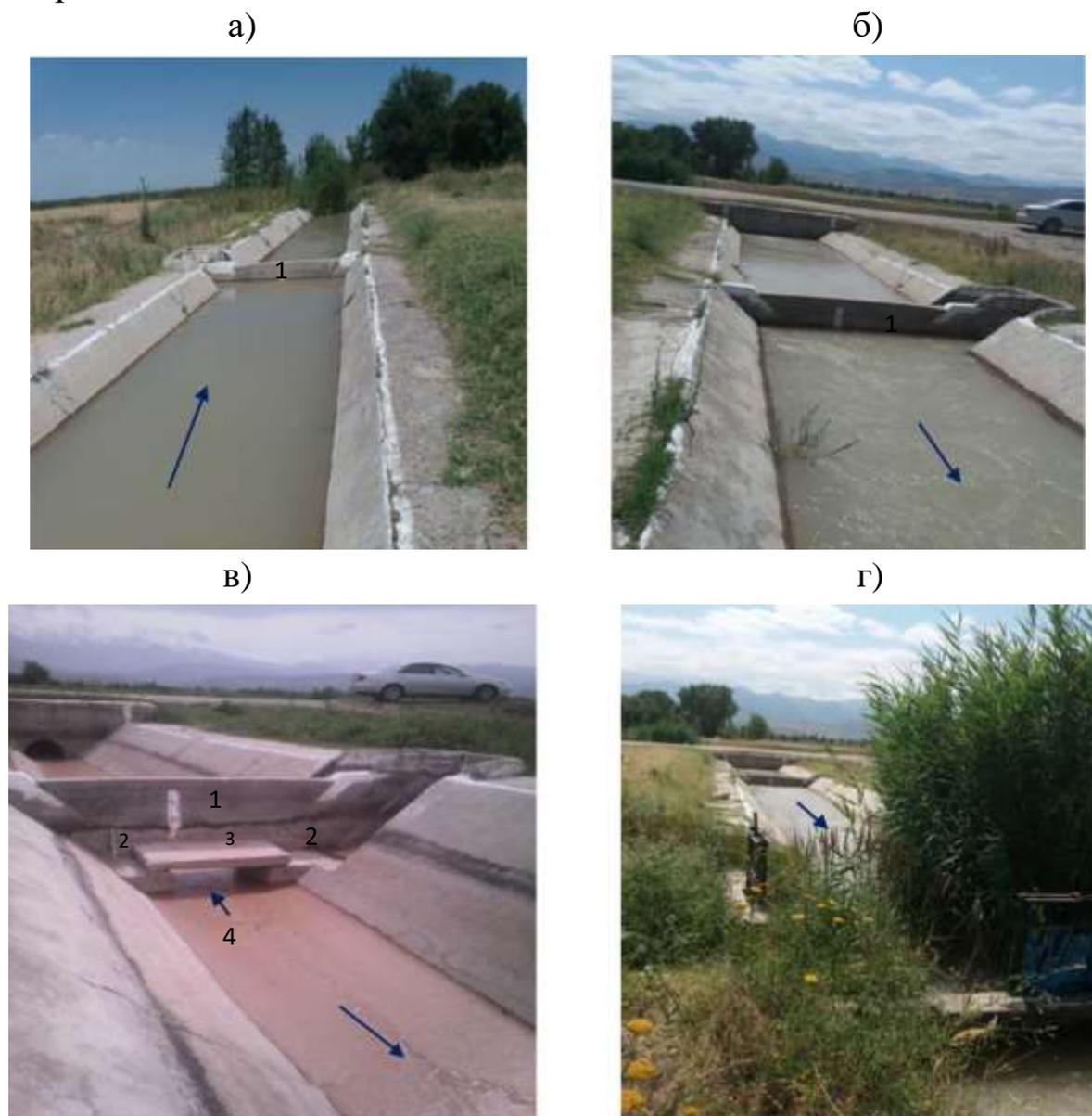
Рис. 3.19. Водомерное сооружение типа «Прямоугольный насадок» на Р-21 системы ВБЧК. а – вид с верхнего бьефа; б, в, г – виды с нижнего бьефа. 1 – диафрагма; 2 – низкие ныряющие стенки; 3 – плита; 4 – водопропускное отверстие.
