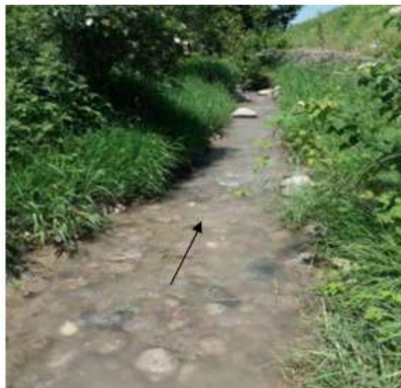
Рис. 1.1. Каналы в земляном русле, трассы которых проходят в предгорной зоне поперек горизонталей. Внутрихозяйственные каналы на системах рек Иссык-Ата (а) и Ала-Арча (б).
