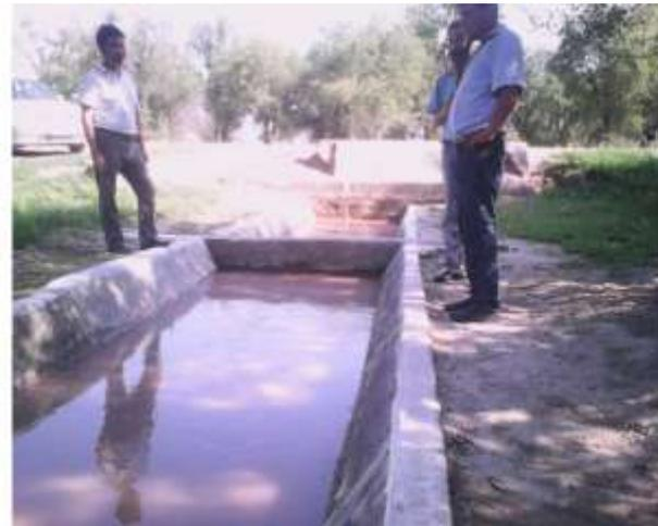
Водомерные сооружения типа «Прямоугольный насадок» на Р-1-1 (а); на Р-1-9 (в); на Р-2-7 (д) – виды с верхнего бьефа; на Р-1-1 (б); на Р-1-9 (г); на Р-2-7 (е) – виды с нижнего бьефа системы ЗБЧК.
