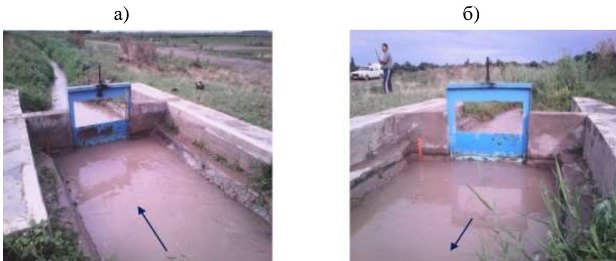
Рис. 3.25. Водомер типа «Водослив-прямоугольный насадок» на Р-8 системы ЗБЧК (замер воды осуществляется насадком). а – вид с верхнего бьефа; б – вид с нижнего бьефа.
