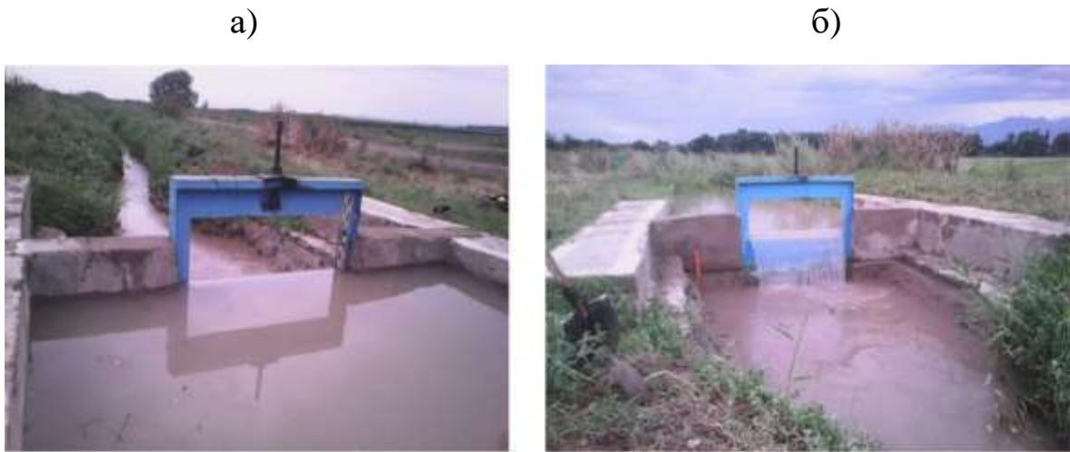
Рис. 2. Водомер типа «Водослив-прямоугольный насадок» на Р-8 системы ЗБЧК (замер воды осуществляется водосливом). а – вид с верхнего бьефа; б – вид с нижнего бьефа.
