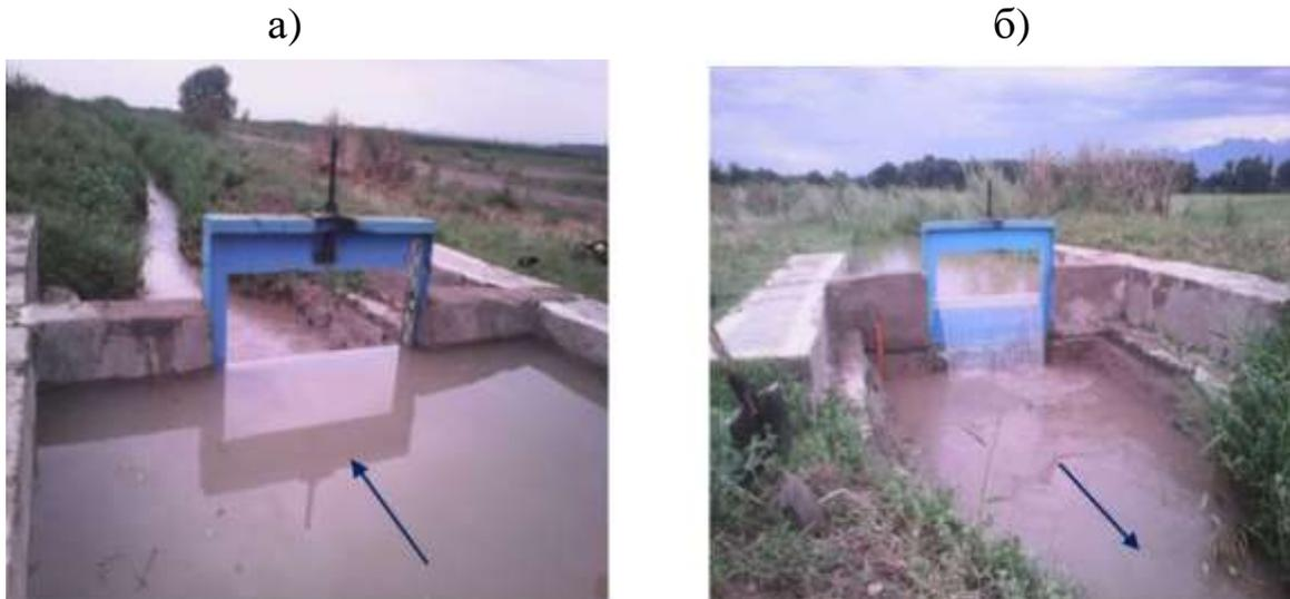
Рис. 3.24. Водомер типа «Водослив-прямоугольный насадок» на Р-8 системы ЗБЧК (замер воды осуществляется водосливом). а – вид с верхнего бьефа; б – вид с нижнего бьефа.
