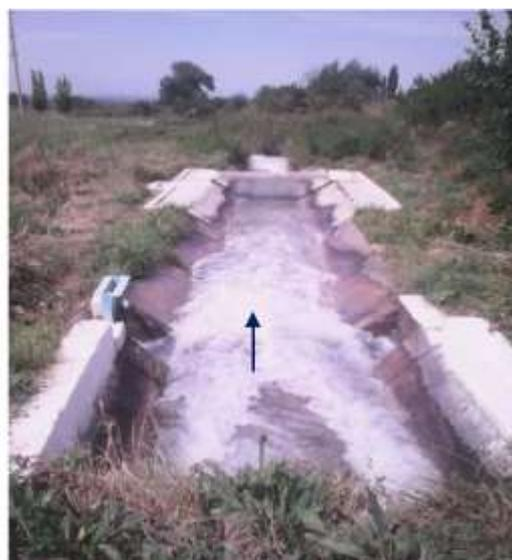
Рис. 2.10. Гидропосты типа «Фиксированное русло», размещенные в головной части отводов, но в некотором удалении от трубчатых водовыпусков.
