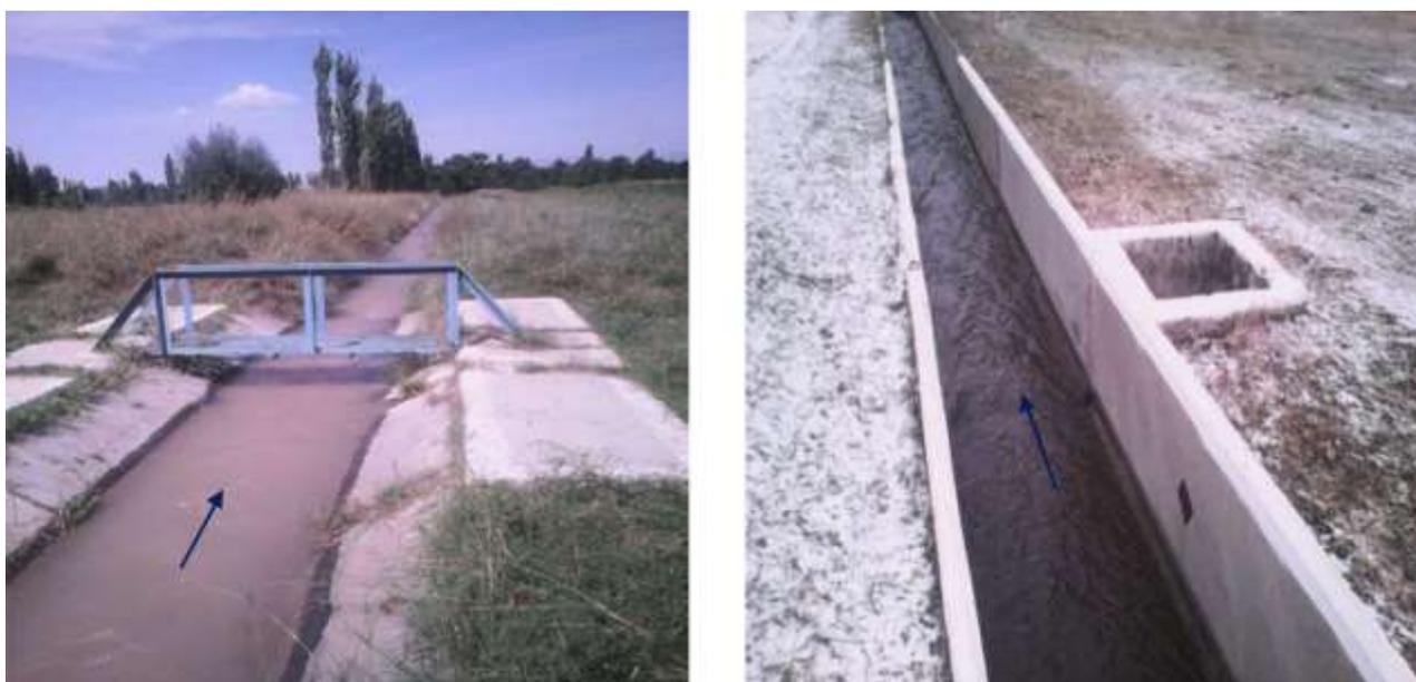
Рис. 2.6. Водомерные сооружения типа «Фиксированное русло» на облицованных каналах.
