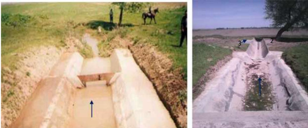
Рис. 3.14. Водомеры типа «Прямоугольный насадок» (а) и «Фиксированное русло» (б) на Р-20-2 системы ЗБЧК (виды с верхнего бьефа). 1 – диафрагма; 2 – лоток; 3 – колодец.
