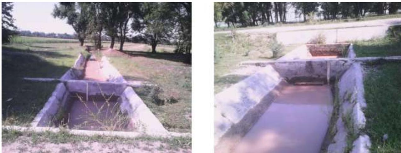
Рис. 2. Водомерное сооружение типа «Прямоугольный насадок» на Р-2-6 ЗБЧК. а, б - соответственно виды с верхнего и нижнего бьефов.
