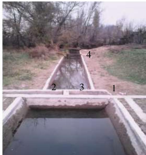
Рис. 2.21. Водомерные сооружения типа «Конусный насадок».
