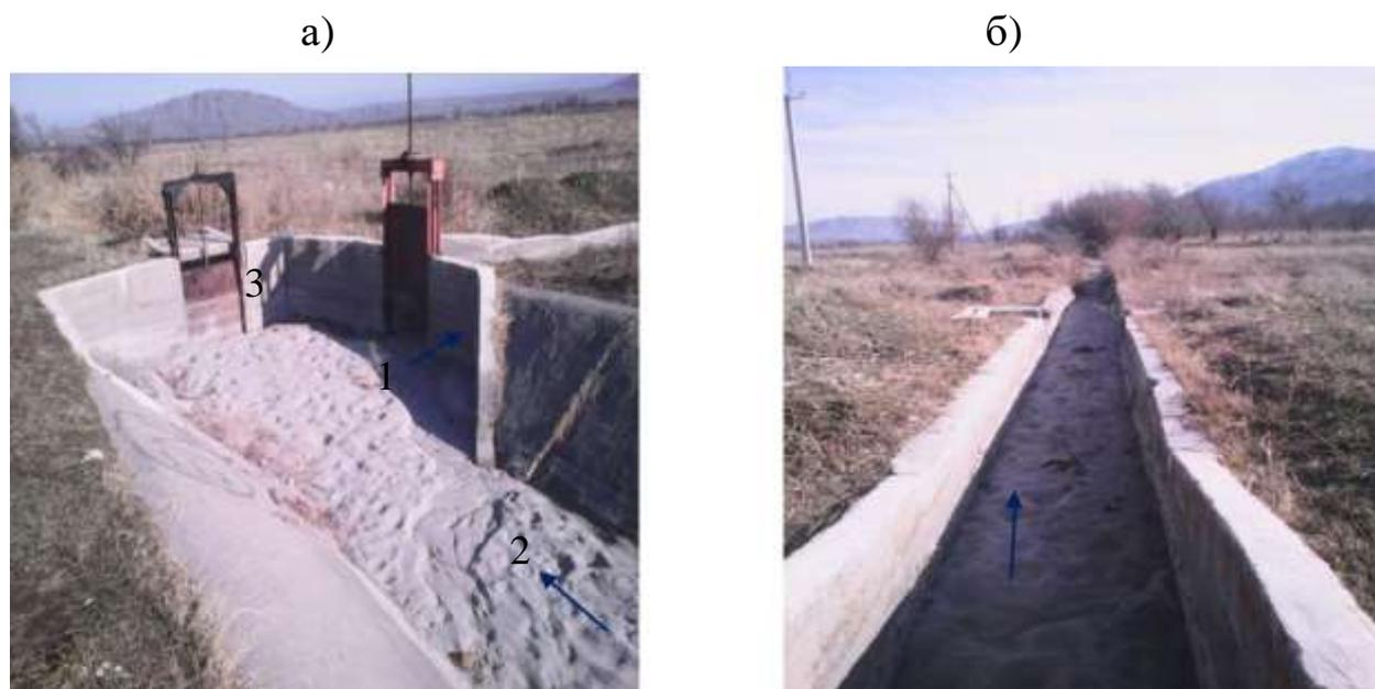
Рис. 2.7. Водораспределитель на отводе из МК «Туш» (а) и гидропост на канале Орто-Алыш (б). 1 – вход в канал Орто-Алыш; 2 – наносы в виде песка; 3 – затвор.
