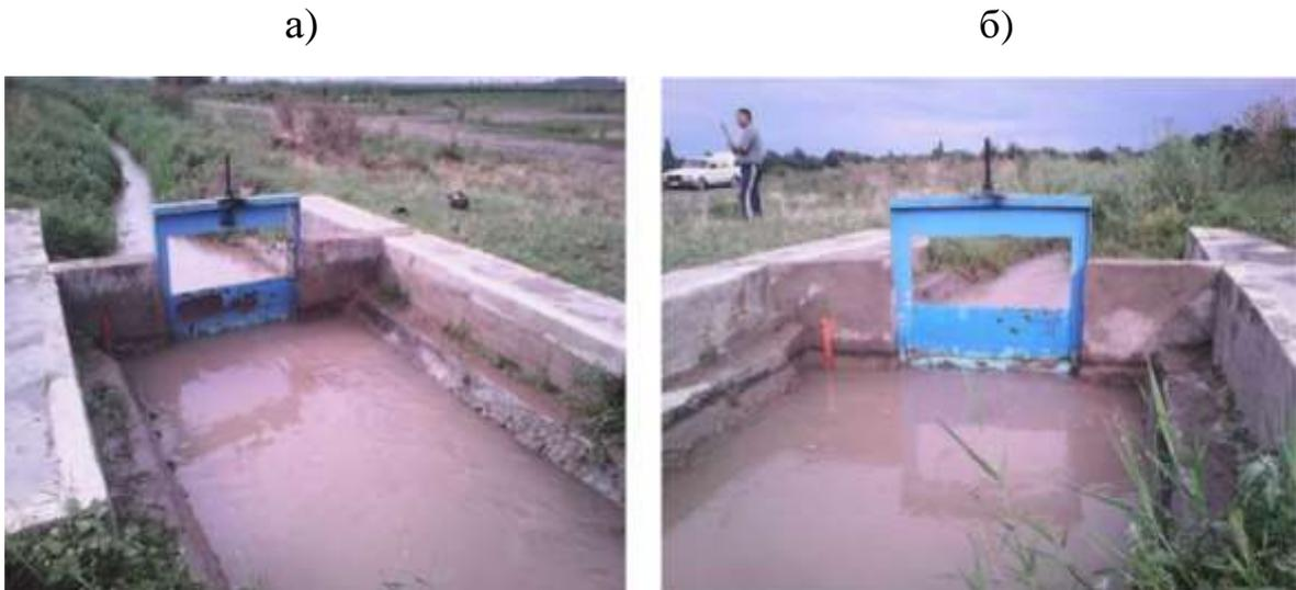
Рис. 3. Водомер типа «Водослив-прямоугольный насадок» на Р-8 системы ЗБЧК (замер воды осуществляется насадком) а – вид с верхнего бьефа; б – вид с нижнего бьефа.
