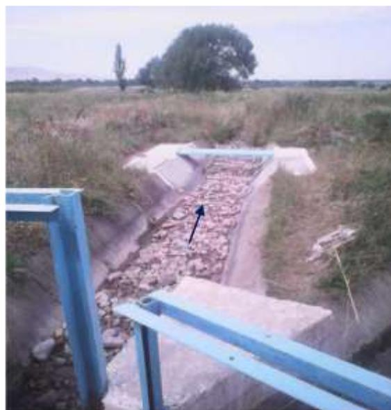
Рис. 2.5. Водомерные сооружения типа «Фиксированное русло», построенные в предгорной зоне поперек горизонталей.
