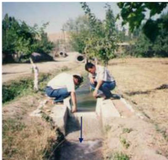
Рис. 3.1. Стационарные водомерные сооружения типа «Водосливы с тонкой стенкой» на оросителях младшего порядка. а – вид с верхнего бьефа; б – вид с нижнего бьефа.
