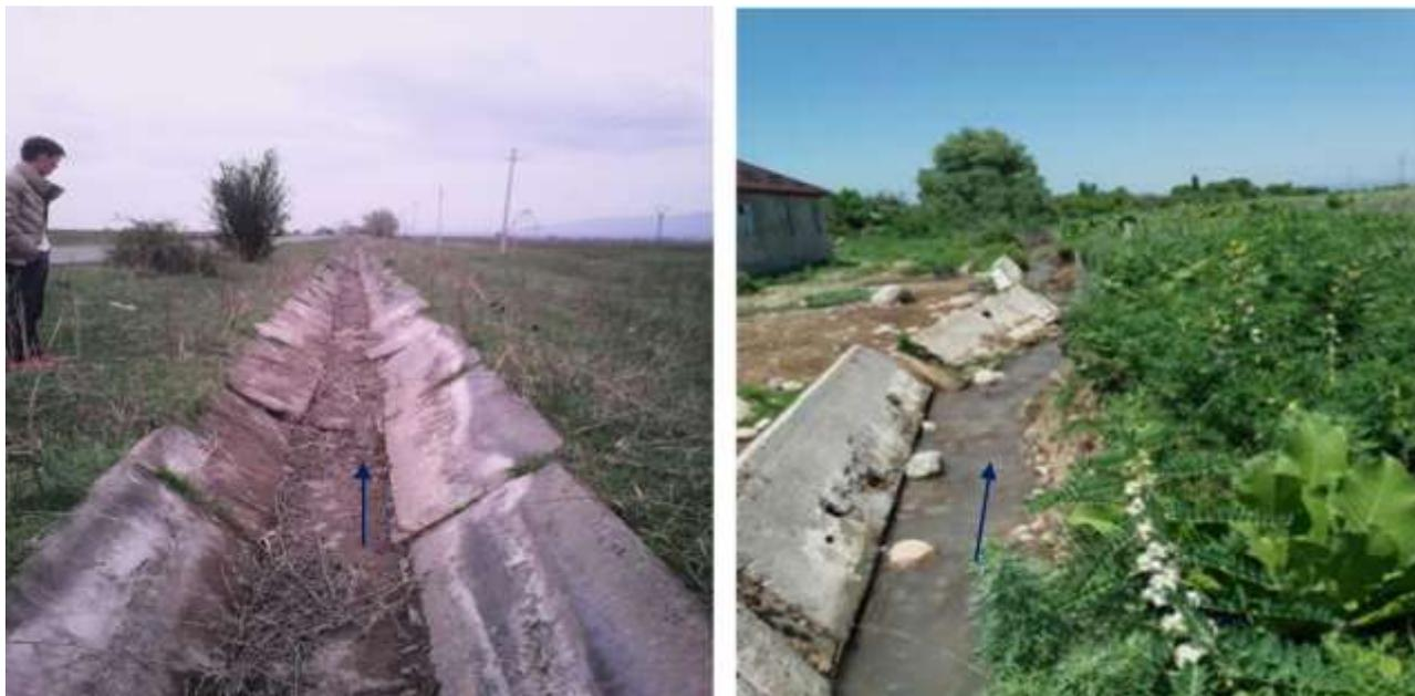
Рис. 1.6. Каналы, облицованные железобетонными плитами.
