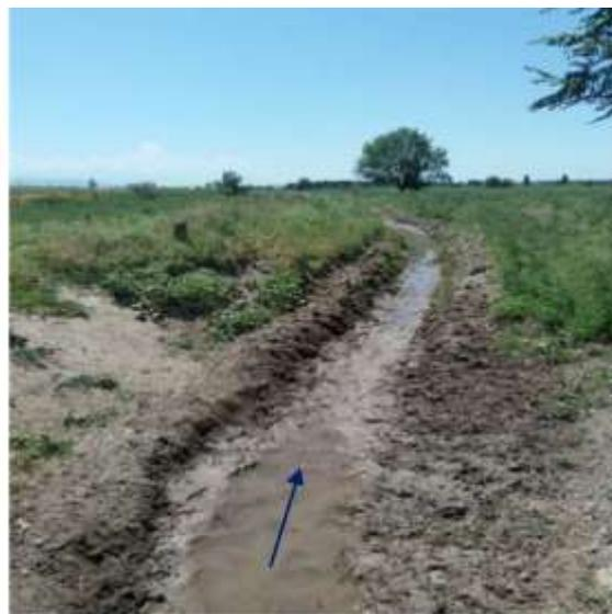
Рис. 1.2. Каналы в земляном русле, трассы которых проходят в предгорной зоне вдоль горизонталей. Внутрихозяйственные каналы Р-12-12 системы ВБЧК (а) и Р-10 левый системы ЗБЧК (б).
