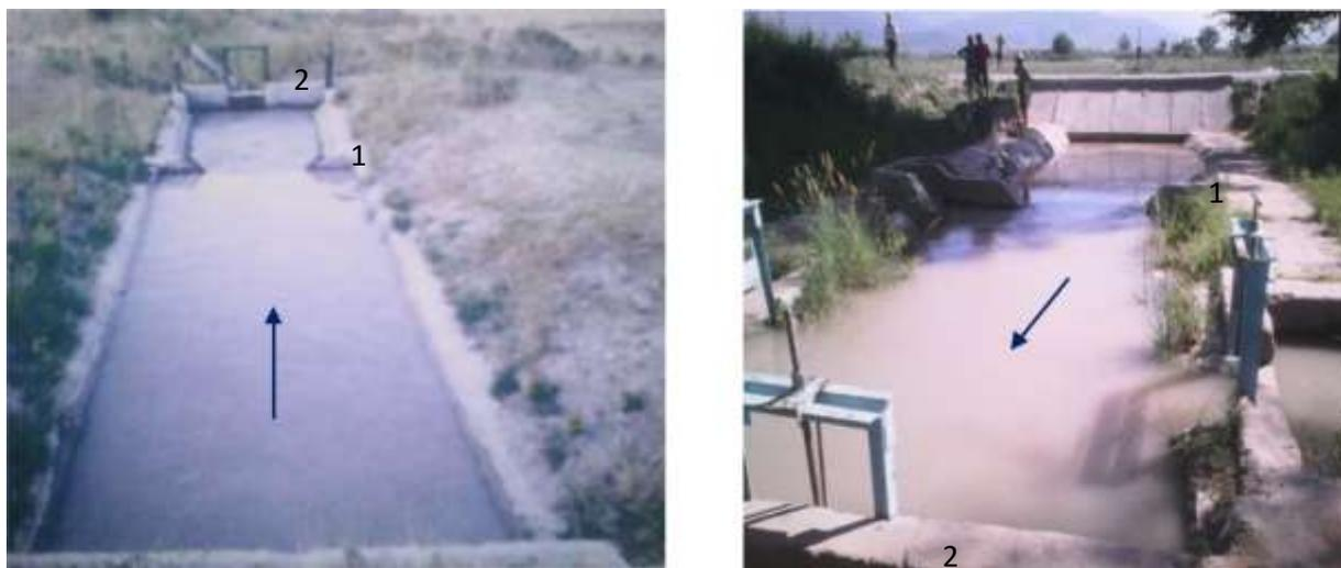
Рис. 3.34. Водомеры типа «Водосливы с тонкой стенкой» размещены между двумя сетевыми сооружениями – трубчатыми водовыпусками и водораспределительными сооружениями (водосливы с тонкой стенкой подтоплены). 1 – водосливы с тонкой стенкой; 2 – водораспределительные сооружения.
