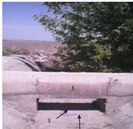
Рис. 3.15. Водомер типа «Прямоугольный насадок» на Р-20-3 системы ЗБЧК. а – первоначально построенном виде, б – отсутствуют металлоконструкции сооружения (разобраны и украдены). 1 – диафрагма; 2 – щитовая часть; 3 – водопропускное отверстие.
