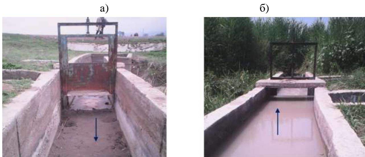
Рис. 3.30. Водомерное сооружение типа «Водослив-прямоугольный насадок» на Р-4-2 системы ВБЧК. Водомерное сооружение без воды (а - вид с нижнего бьефа); водомерное сооружение в работе – замер воды осуществляется прямоугольным водосливом (б - вид с верхнего бьефа).
