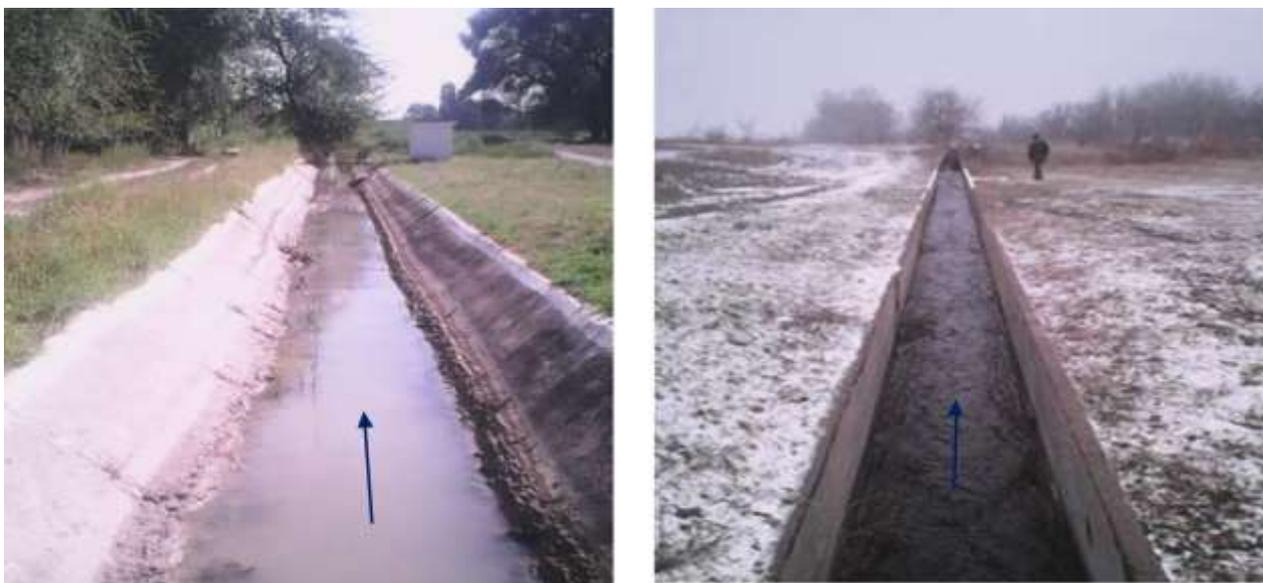
Рис. 1.5. Каналы в бетонной облицовке.
