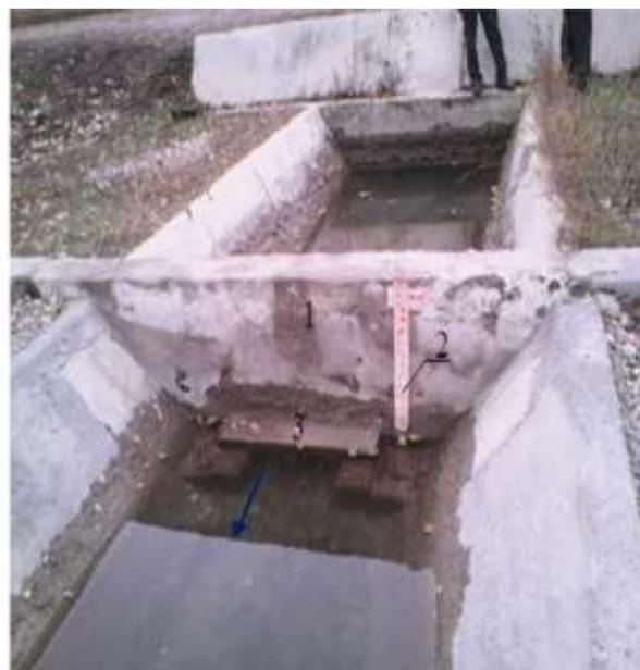
Рис. 3.17. Водомерное сооружение типа «Прямоугольный насадок» на распределителе Р-2-6 системы ЗБЧК. а – вид с верхнего бьефа; б – вид с нижнего бьефа. 1 – диафрагма; 2 – рейка; 3 – верх насадка.
