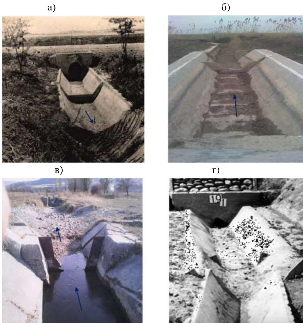
Рис. 2.19. Водомерные сооружения типа «Водосливы с тонкой стенкой», не пригодные к измерению расходов воды.
