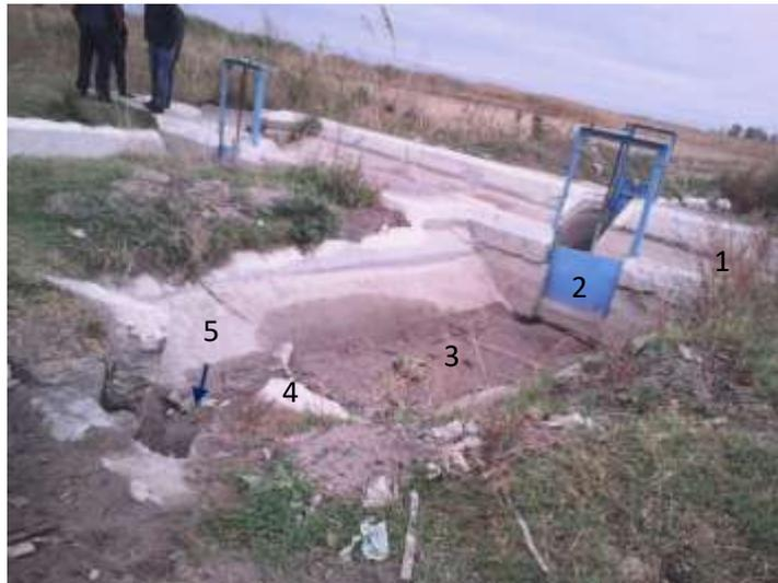
Рис. 3.36. Водомер с водосливом в конце успокоительного колодца с неуглубленным дном. 1 – отвод Р-9 из ЗБЧК; 2- щит; 3 – успокоительный колодец-гаситель; 4 – бетонная диафрагма; 5 – разрушенный водослив с тонкой стенкой.
