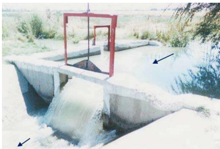
Рис. 3.41. Водомерное сооружение на Р-7-13 прямо системы АМК.
