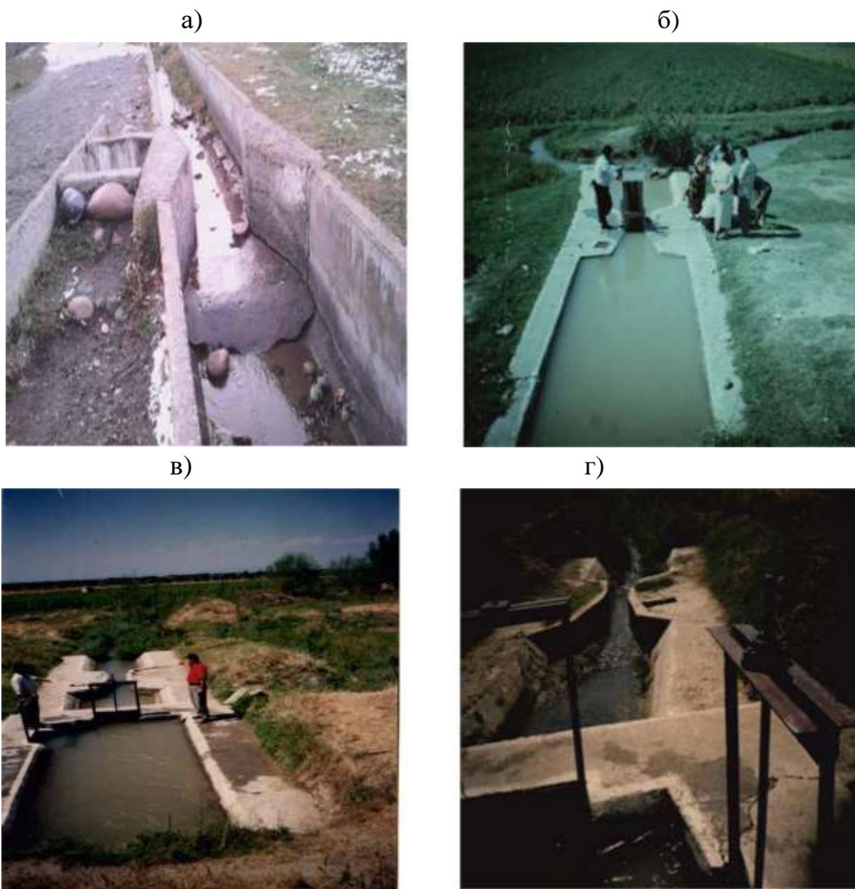
Рис 2.20. Водомерные сооружения типа «Лотки» Вентури. а – на канале «Желамыш» системы реки Желамыш; б, в, г – на отводах канала Савай системы реки Кара-Дарья.
