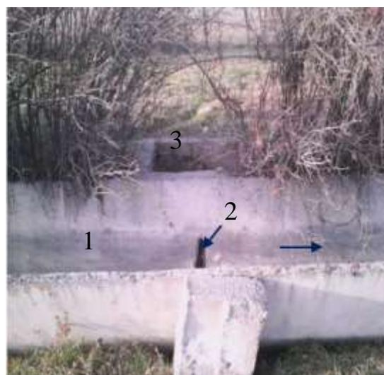
Рис. 2.9. Водомер типа «Фиксированное русло» на лотковом канале «Жантай» системы реки Ала-Арча. а - общий вид с верхнего бьефа; б - вид сбоку. 1 – лоток; 2 – щель; 3 – уровнемерный колодец.
