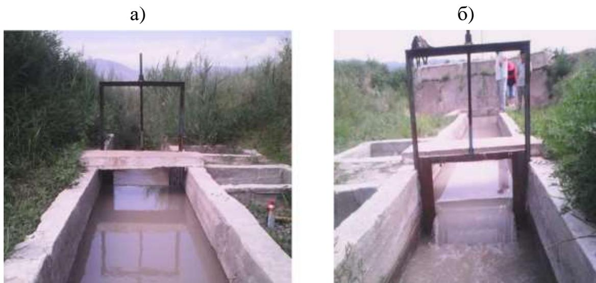
Рис. 3.31. Водомерное сооружение типа «Водослив-прямоугольный насадок» на Р-4-3 системы ВБЧК. Водомерное сооружение в работе – замер расходов воды осуществляется прямоугольным водосливом. а – вид с верхнего бьефа; б – вид с нижнего бьефа.
