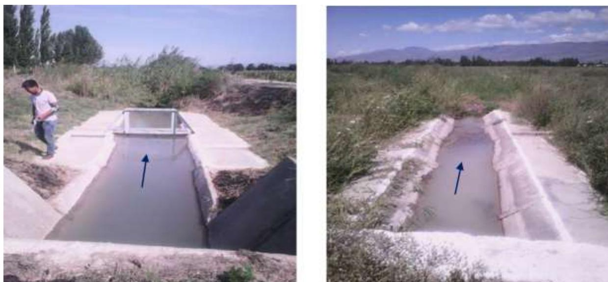
Рис. 2.12. Гидропосты типа «Фиксированное русло», размещенные на выходе из трубчатых водовыпусков.
