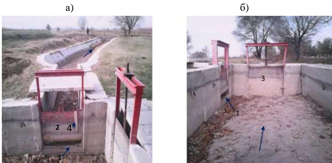
Рис. 3.42. Водораспределительный узел на Р-10 ЗБЧК (вид с верхнего бьефа). а – отвод Р-10 левый; б – отвод Р-10 прямой. 1 – вход в прямоугольный насадок; 2 – щит в голове отвода Р-10 левый; 3 – щит в голове отвода Р-10 прямой; 4 – уровнемерная рейка.
