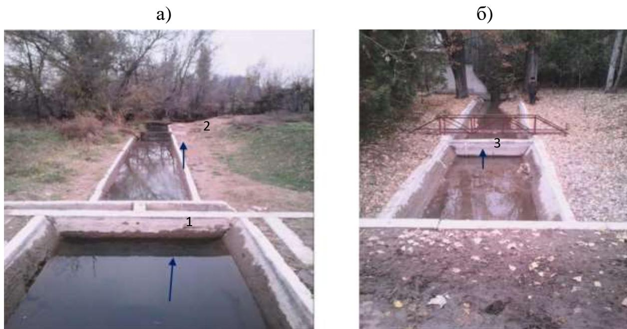
Рис. 3.47. Водомерные сооружения типов «Конусный насадок» (1), «Фиксированное русло» (2) и «Прямоугольный насадок» (3).
