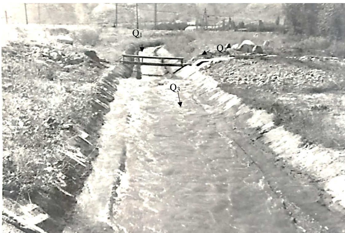
Рис.5.7. Подпитывающее сооружение на канале Даирбек с.р.Норус.
