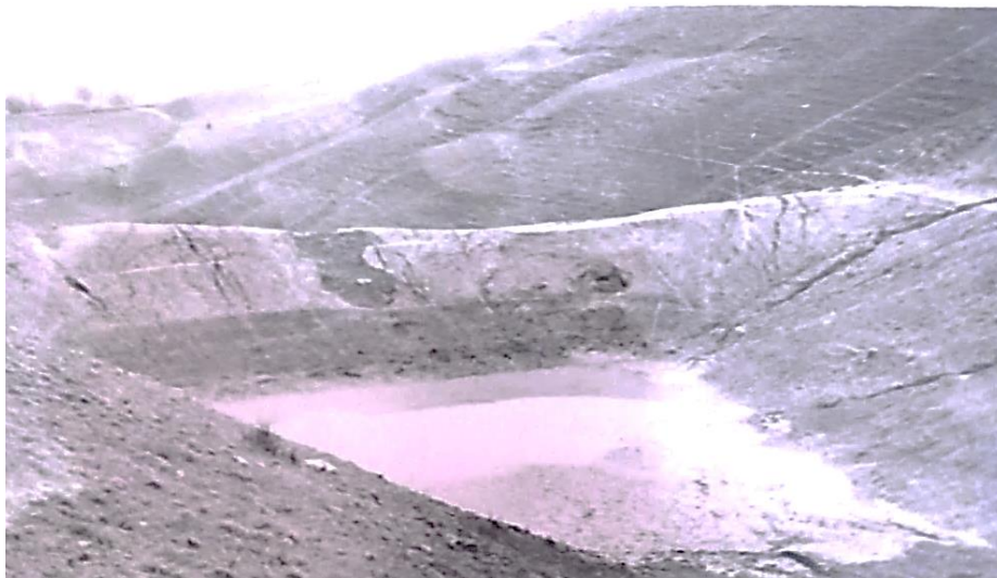
Рис.2.2. Селеудерживающая емкость на логу (вид с верхнего бьефа) Кыргыз-Атинская оросительная система.
