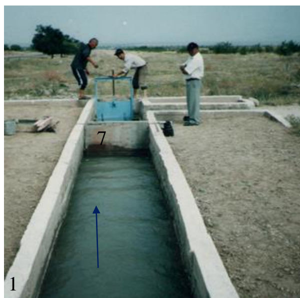
Рис. 9.28. Водомерные сооружения типов «Фиксированное русло» (а) и «Прямоугольный насадок» (б) на Р-12-12 системы ВБЧК.
