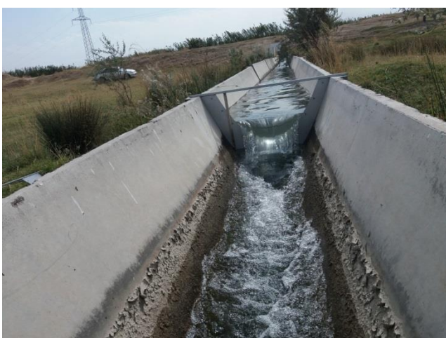
Рис. 9.61. Водомерные сооружения с тонкими водосливами на лотковых каналах. а, б, в, г – водосливы соответственно треугольного, трапецидального, прямоугольного и параболического поперечных сечений.
