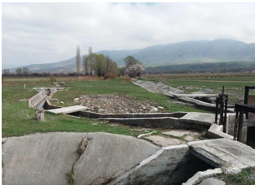
Рис.9.52. Отвод «Садовый» из канала «Туш» с.р. Ала-Арча. 1 – затвор; 2 – прямоугольный водовод; 3 – параболический лоток; 4 – гидрост (водослив); 5 – регулятор. 1-1-створ размещения нового прямоугольного водослива.
