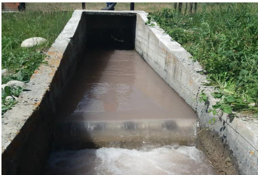
Рис.9.55. Водослив в работе (вид с нижнего бьефа).
