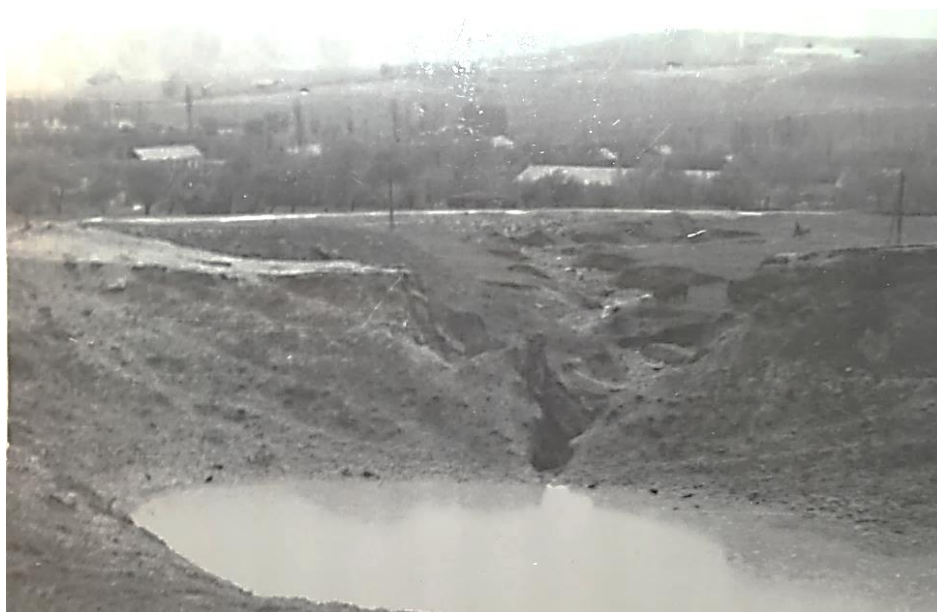
Рис.2.3. Селеудерживающая емкость на логу Терек-Сай (вид с верхнего бьефа) Кыргыз-Атинская оросительная система.
