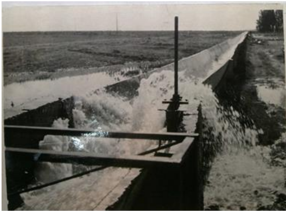
Рис.8.3. Водораспределитель с запрудом временного характера и гидравлический режим его работы.
