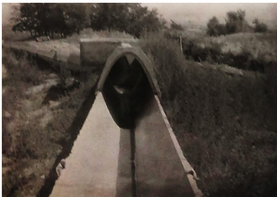
Рис. 6.3. Поворотное сооружение на лотковом канале (Московский район).
