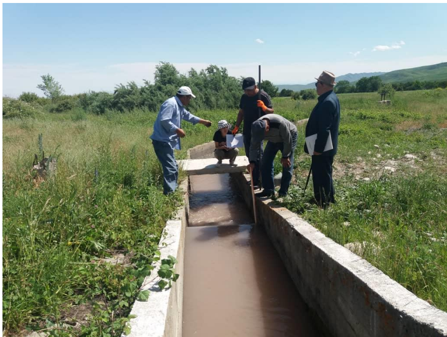
Рис.9.54. Водослив построен. Идет процесс оснащения водомера уровнемерной рейкой (вид с верхнего бьефа).
