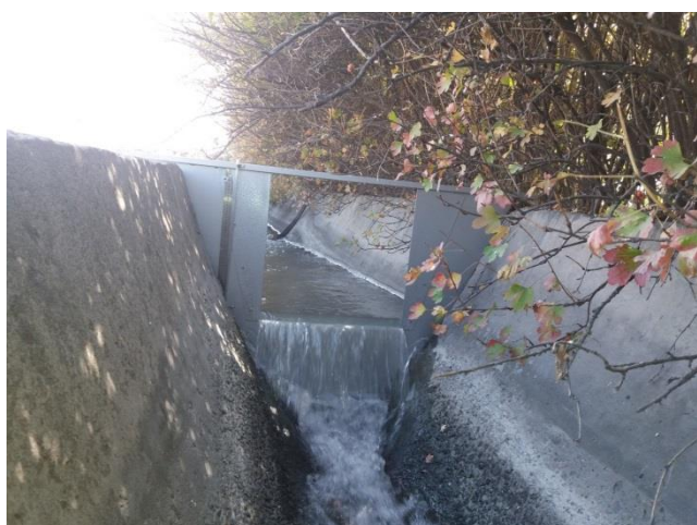
Рис. 9.61. Водомерные сооружения с тонкими водосливами на лотковых каналах. а, б, в, г – водосливы соответственно треугольного, трапецидального, прямоугольного и параболического поперечных сечений.
