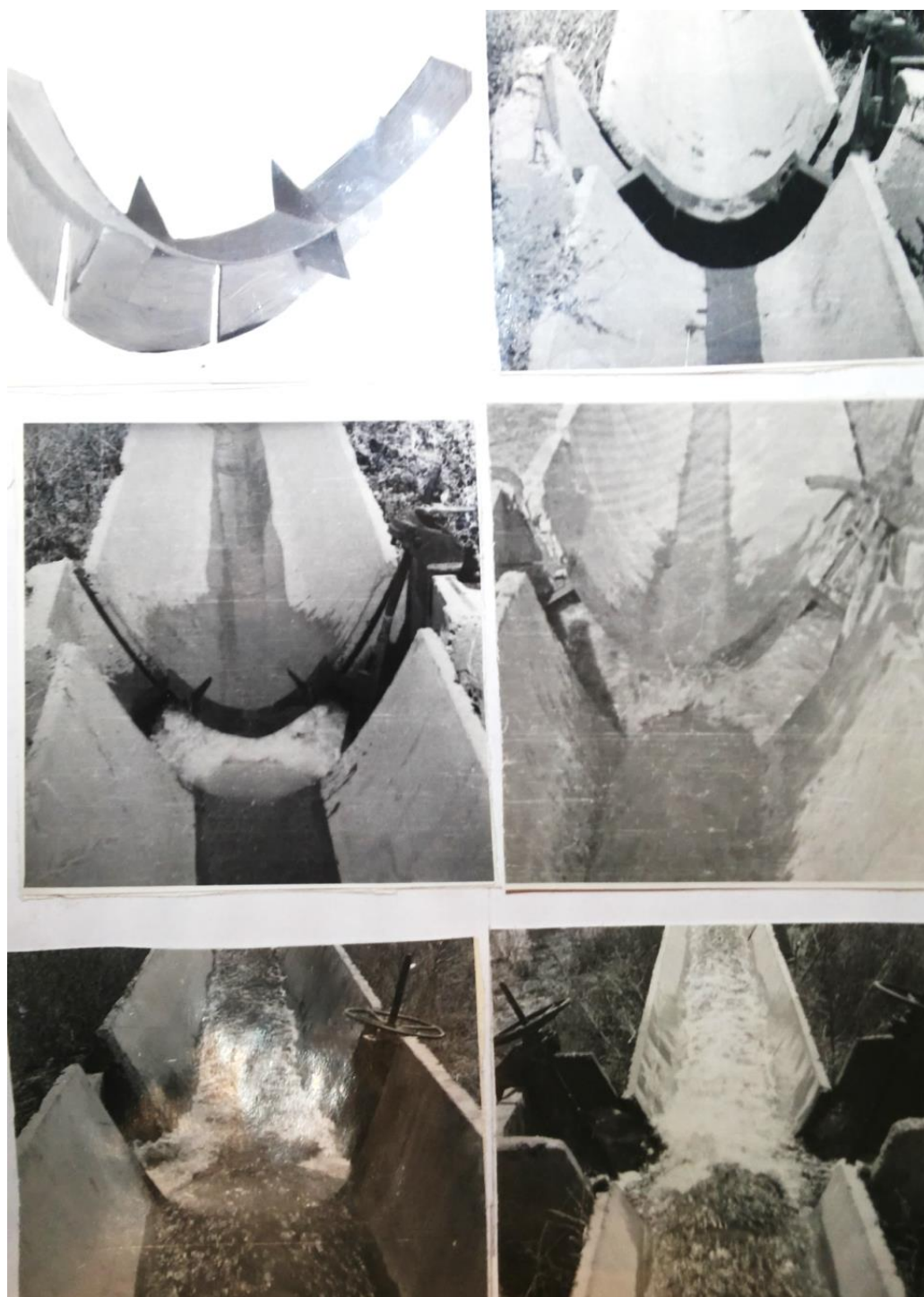
Рис.8.5. Водораспределители с козырьками и гидравлические режимы их работы.
