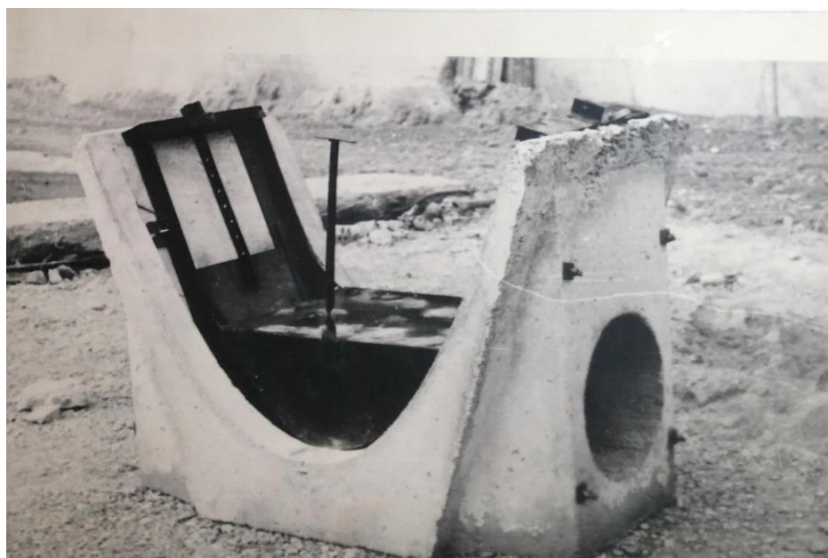
Рис.8.8. Новый блок ВС и ДВС для водораспределителей лотковых каналов (на Ленинском полигоне Кен-Булунского ЖБИ).
