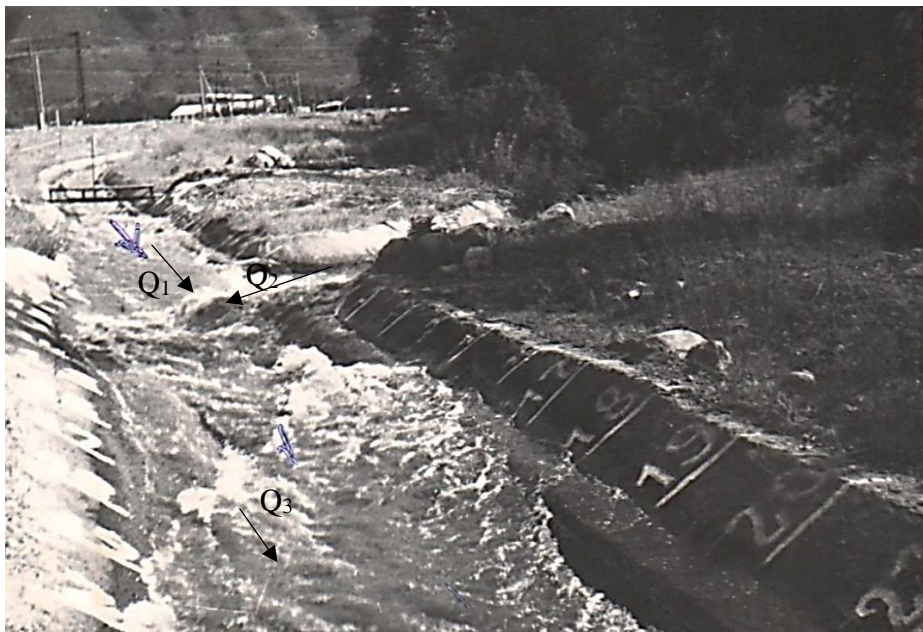
Рис. 5.5. Подпитывающее сооружение на канале Даирбек системы р. Норус (до реконструкции).
