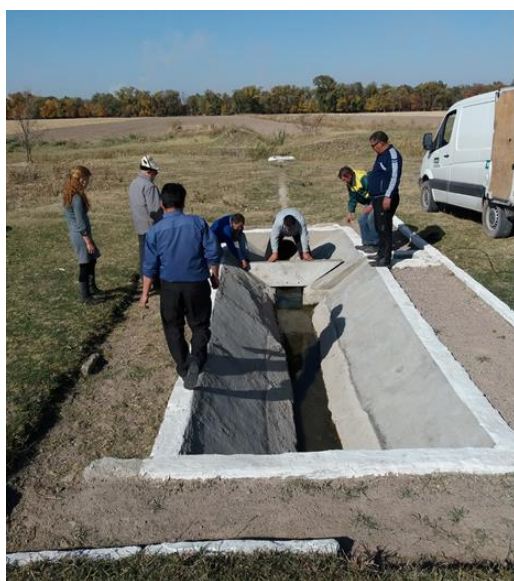
Рис.9.58. Строительство водомера типа «Насадок» на Р-2-1 ЗБЧК.
