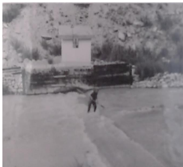
Рис.3.5. Очистка решетки водозаборов на реках Карабалта (а) и Каракол (б) от наносов.
