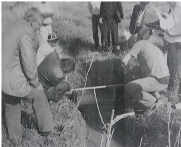
Рис.9.9. Представители Союза АВП КР изучают работу переносного водослива С.Сатаркулова, установленного на участковом распределителе
