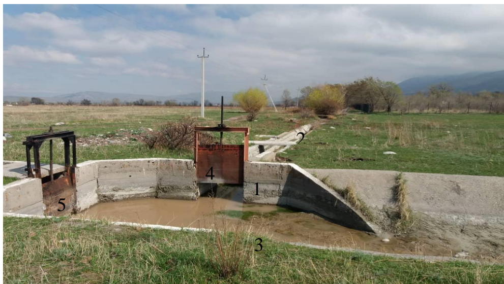
Рис.9.56. Отвод Орто-Альши из канала «Туш» с.р.Ала-Арча. 1 – гидрост типа «Фиксированное русло»; 2 – водораспределитель; 3 – наносы; 4 и 5 – затворы.
