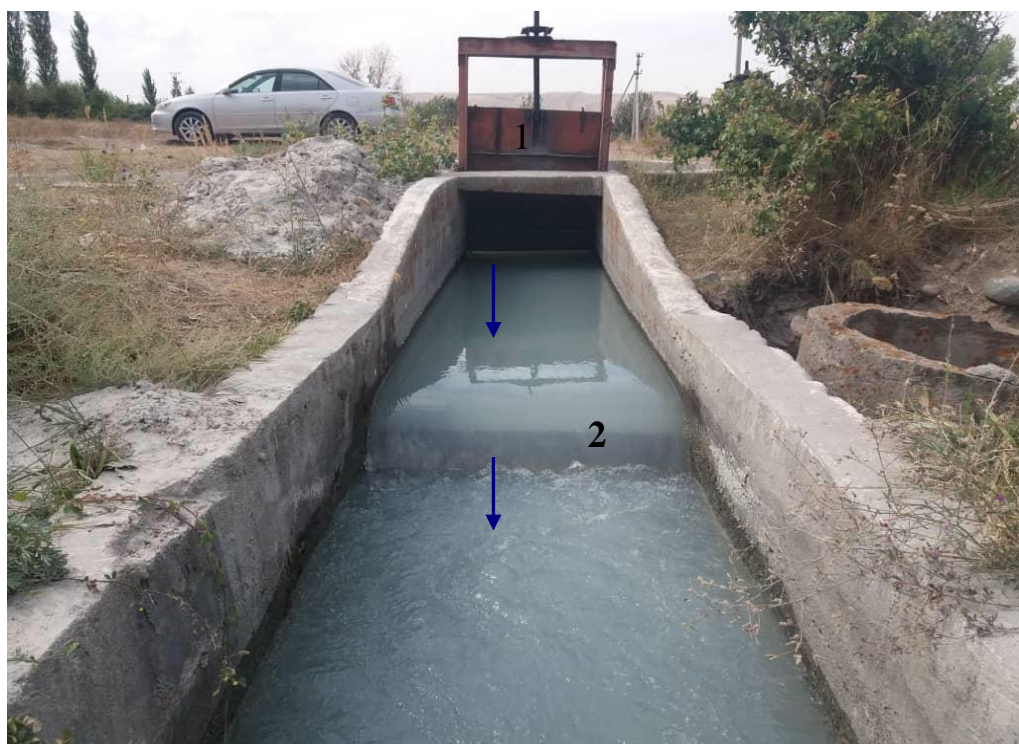
Рис.9.57. Отвод Орто-Альши из канала «Туш» с.р.Ала-Арча. 1 – затвор; 2 – водослив без бокового сжатия. 1 – затвор; 2 – водослив без бокового сжатия.
