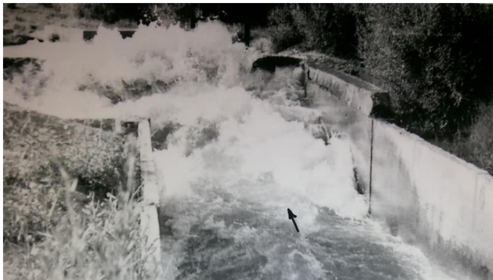
Вид с верхнего бьефа
