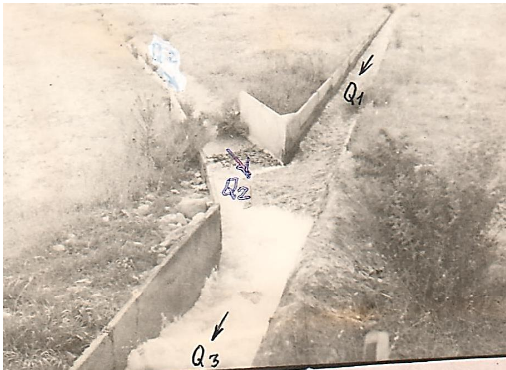
Рис.5.6. Подпитывающее сооружение на канале Мерке системы р.Мерке
