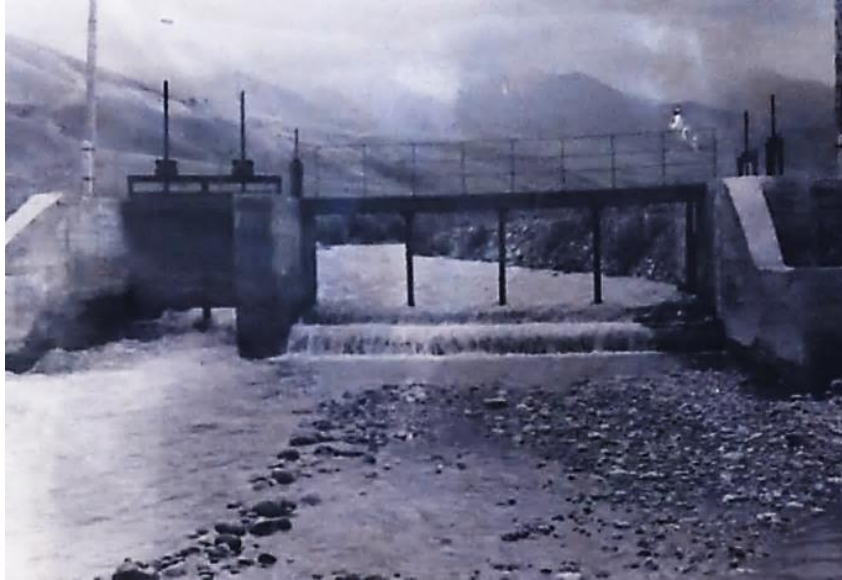
Рис.3.8а. Водозабор с донной решеткой на р.Сокулук (вид с нижнего бьефа).
